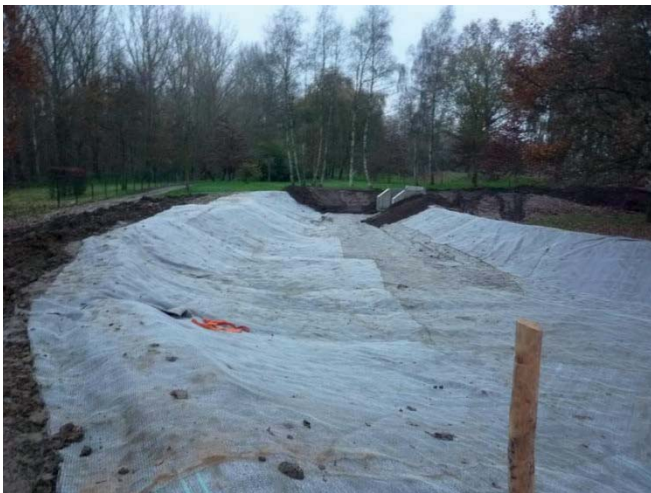
Figuur 26: voorbeeld van de installatie van bentonietmatten in het domein de halve maan te diest. Links: tijdens de installatie. Rechts: het eindresultaat
