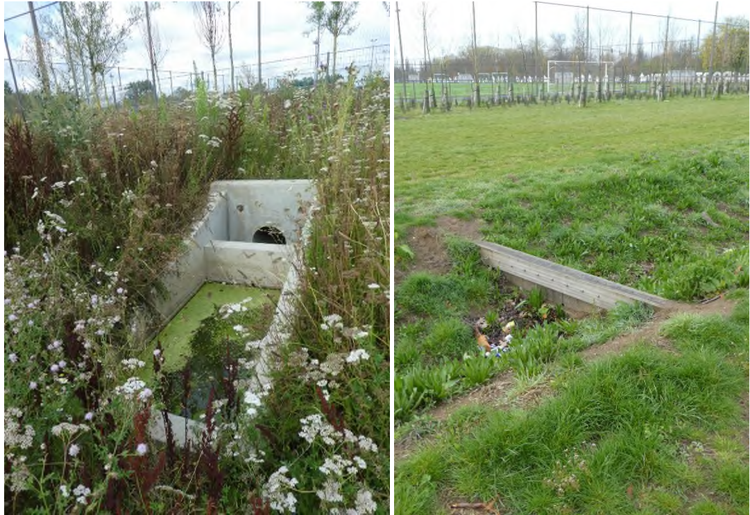
Figuur 2.3-14: Afvoer regenwater van sportterrein naar de wadi; stuwtjes aan de wadi's.
