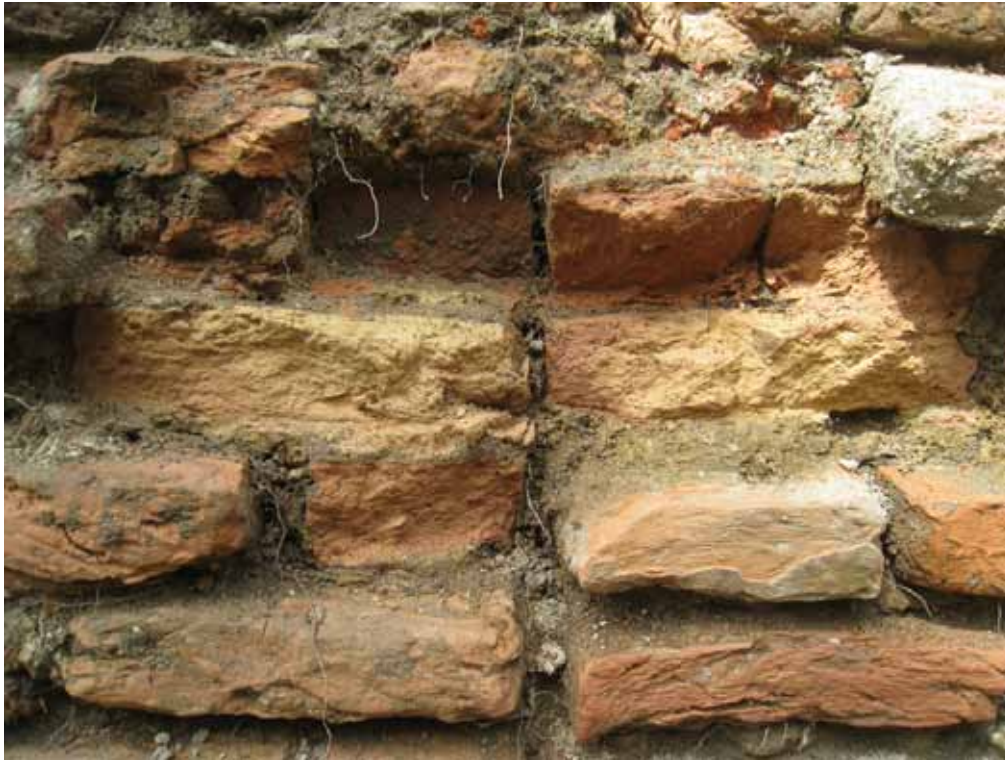
Fig. 19. Bakstenen met lichte kleurenvariatie (geel, rozig, oranje), gemetst met zandmortel. De lichte kleur duidt op een kalkhoudende klei.
