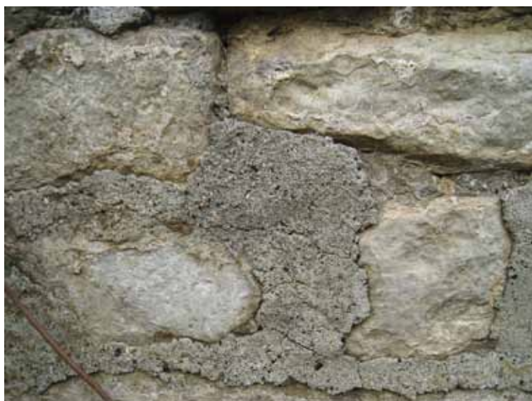
Fig. 53. De onderste rij witte Brusseliaanse steen heeft algemeen minder schade geleden door verwering of desintegratie, doordat die meer zand bevat dan de bovenste rij verweerde Ledesteen.
