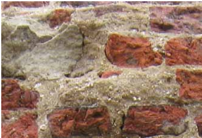
Fig. 55. Baksteenmetselwerk met gelige zavel-kalk mortel, face 1
