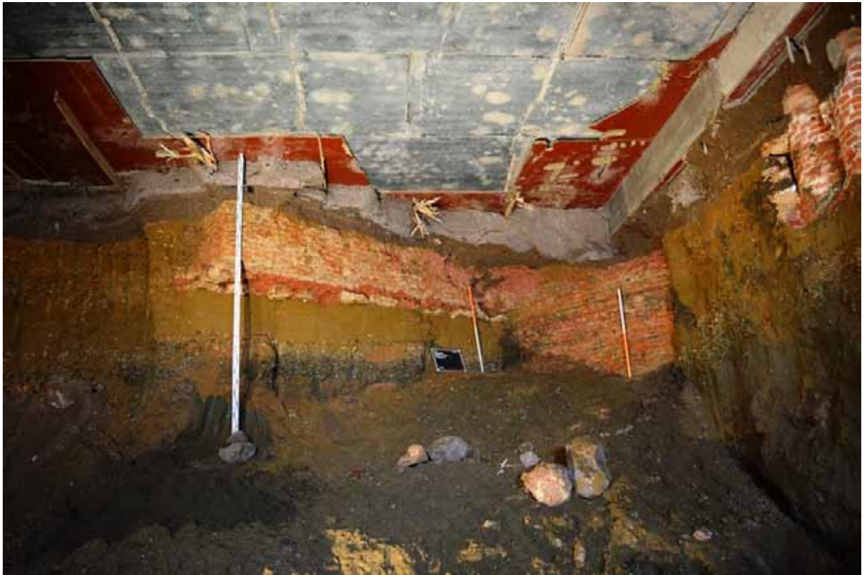
Fig. 11. Het funderingsniveau van steunbeer 8 in de tunnel
