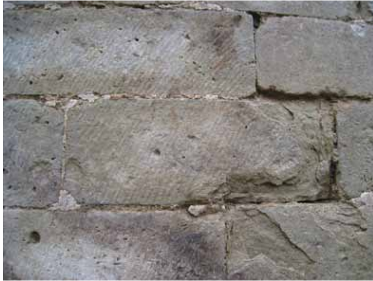
Fig. 51. Ledesteen; desintegratie door afbrokkelen van dunne steenschalen en steenbrokjes aan de buitenranden, veroorzaakt door bevroering
