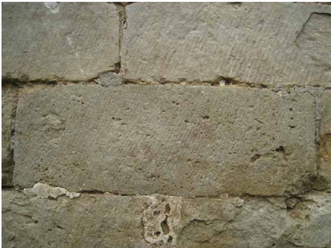
Fig. 54. Schuine ceseelslag op parementsteen
