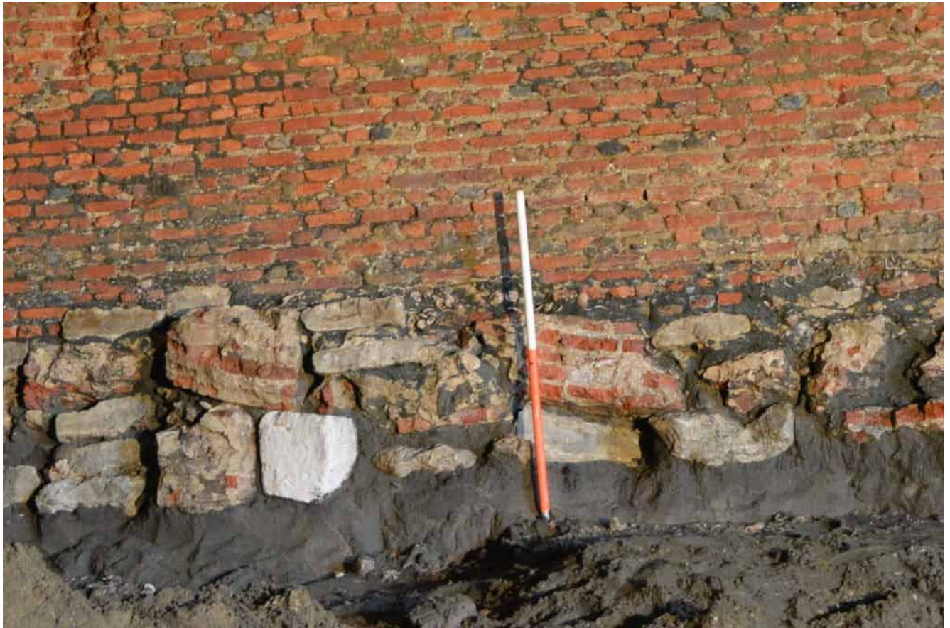
Fig. 23. Fundering uit ruwe blokken zandsteen, kalksteen en voornamelijk sloopafval, tunnelzone
