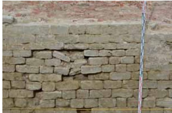
Fig. 52. Mogelijk stukgeschoten parementstenen
