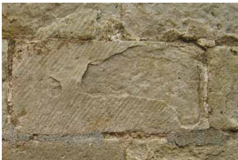
Fig. 50. Ledesteen; afschilfering en loskomen van het gefrijnde oppervlak
