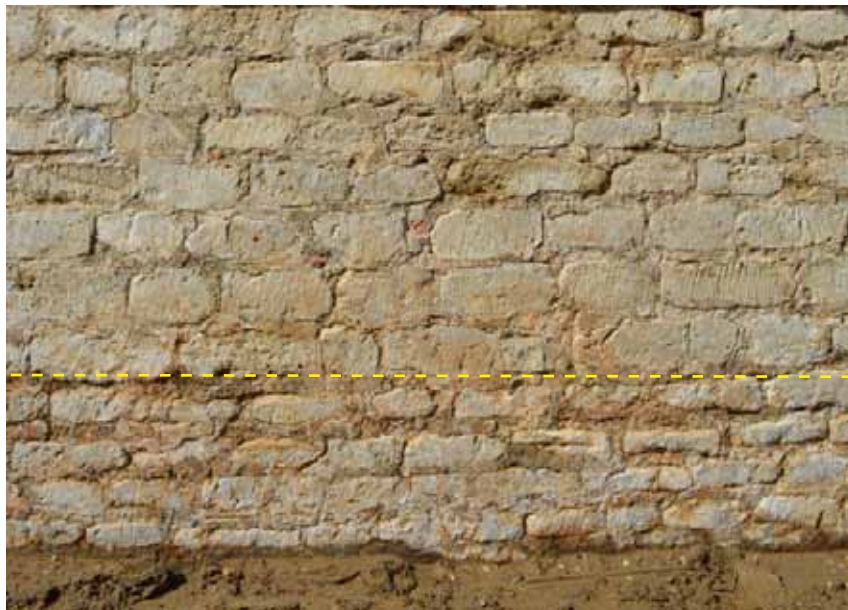
Fig. 36. Witte Brusseliaanse steen onderaan het parement; daarboven volgen de dikkere bouwblokken Ledesteen, face 1, parement zuidelijke muur
