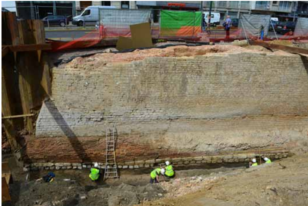
Fig. 7. Van de zuidelijke voorzijde (face) werd in de eerste fase ca. 35m van de geschatte 56m vrij gelegd. Deze voorzijde met baksteenbasis en krijtstenen voet werd opgekuist.
