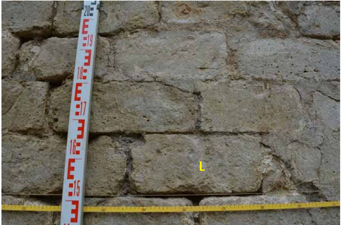
Fig. 26. Parement in Ledesteen (L), 33 x 15 cm, face 1
