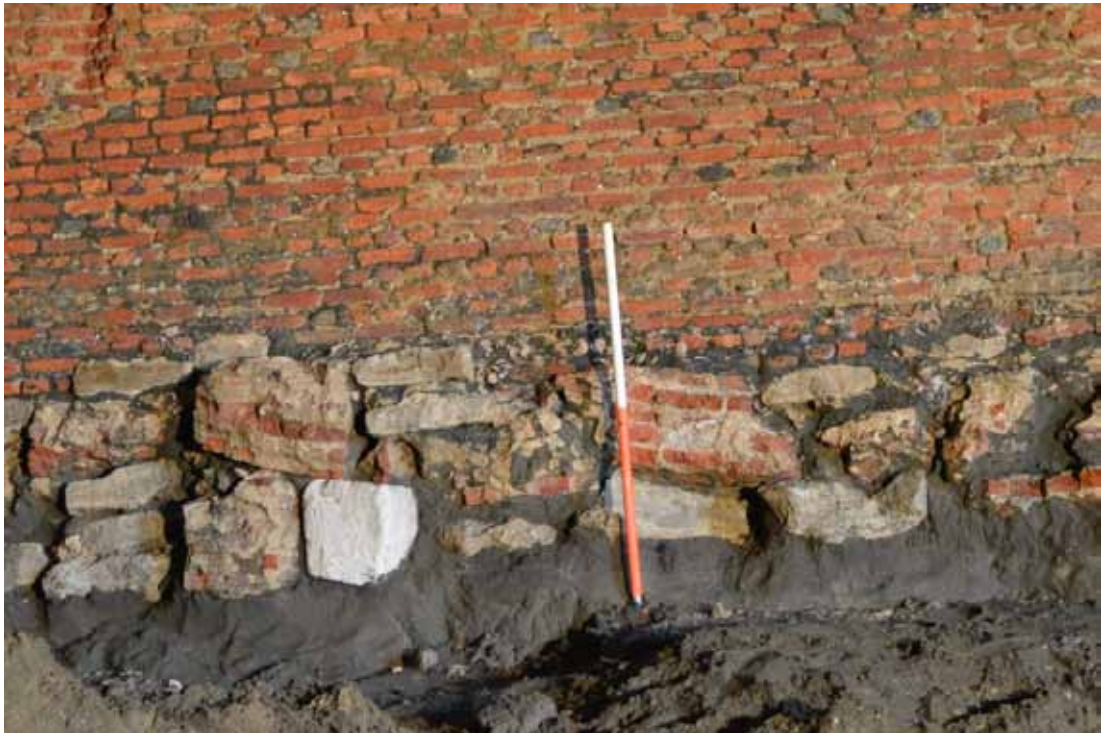
Fig. 8. Funderingsvoet binnenzijde bastionmuur: gemengd gebruik van afbraakmateriaal, krijtsteen en Brusseliaanse kalkzandsteen, tunnelzone. Bemerkt de grote schelpen die zorgen voor een egalisatie tussen natuursteen en baksteen.
