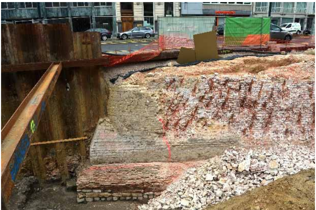
Fig. 26. Een deel van het bastion Huidevetterstoren verdwijnt voor de nieuwe metrotunnel.
