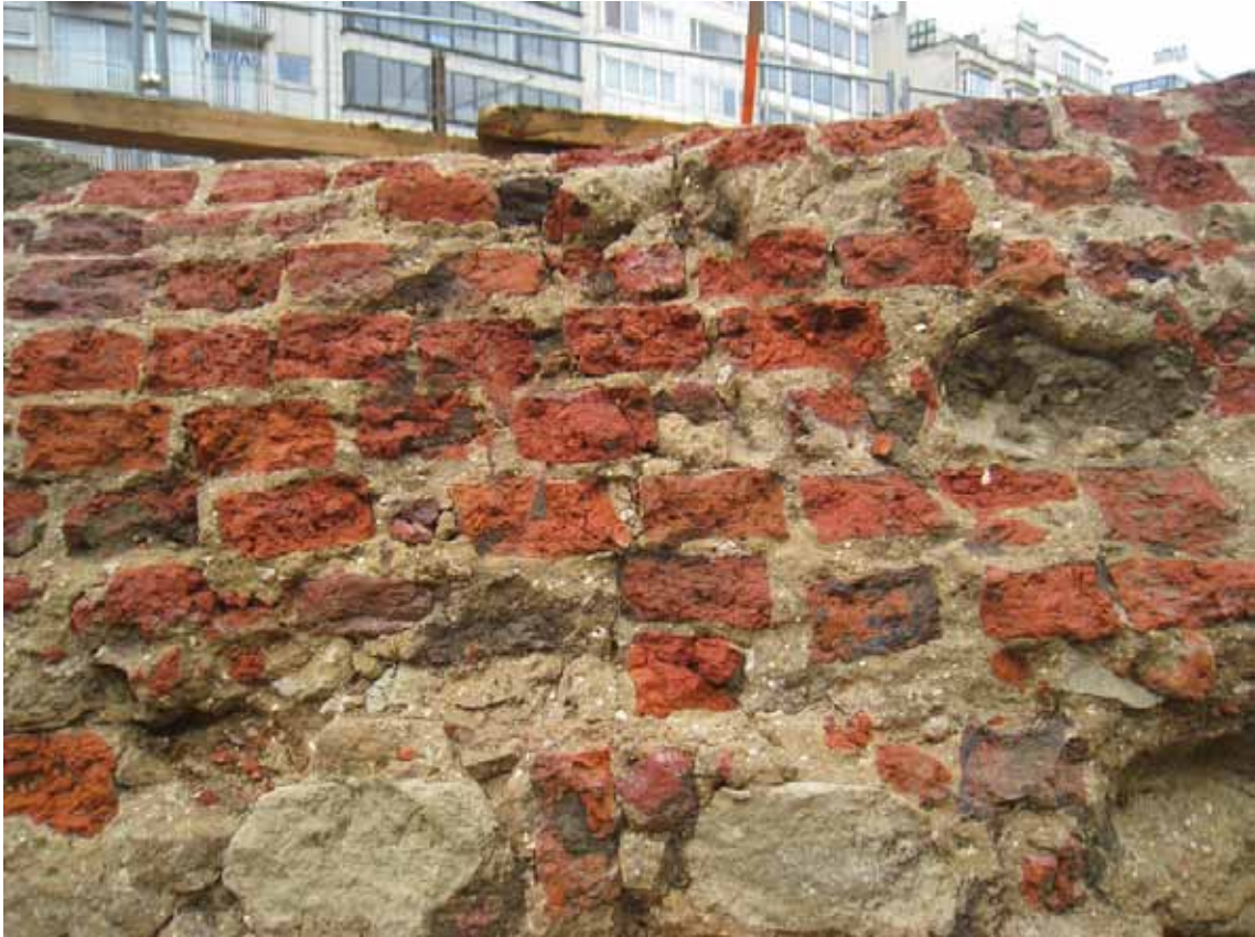
Fig. 17. Variatie van baksteenkleuren in het metselwerk achter het natuurstenen parement
