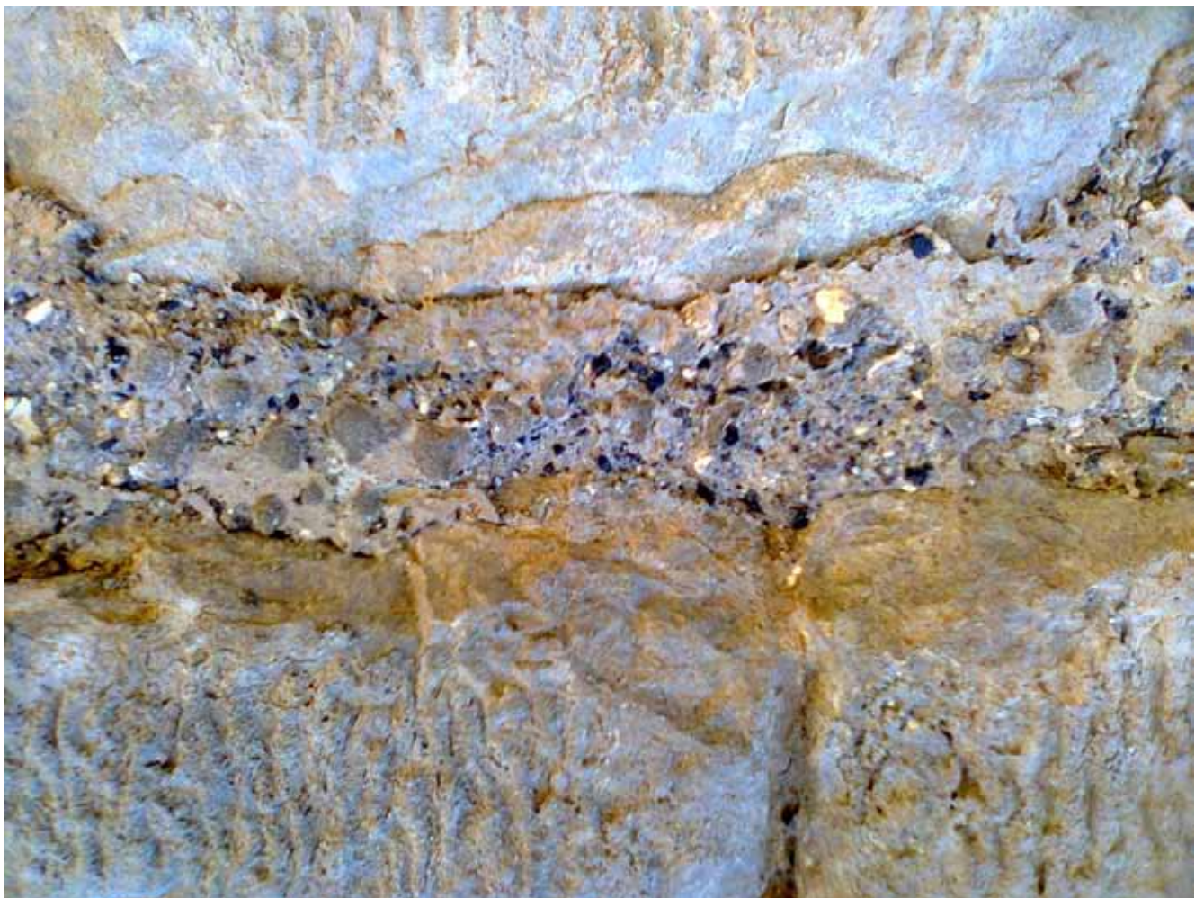
Fig. 61. Negentiende-eeuwse trasmortel tussen de parementstenen (restauratiefase)
