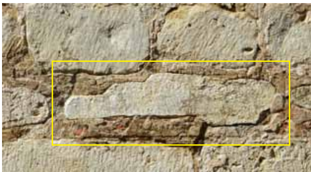
Fig. 20. Geprofileerde bouwelementen herbruikt tussen de parementstenen
