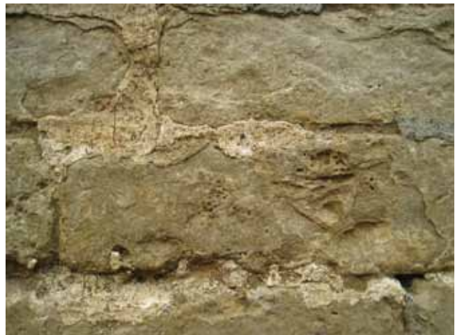
Fig. 58. Herstelling van het parement met witte opvoegmortel en grijze trasmortel, face bastionpunt
