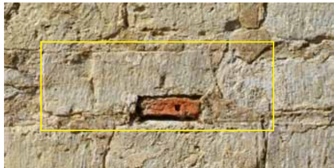
Fig. 20. Geprofileerde bouwelementen herbruikt tussen de parementstenen
