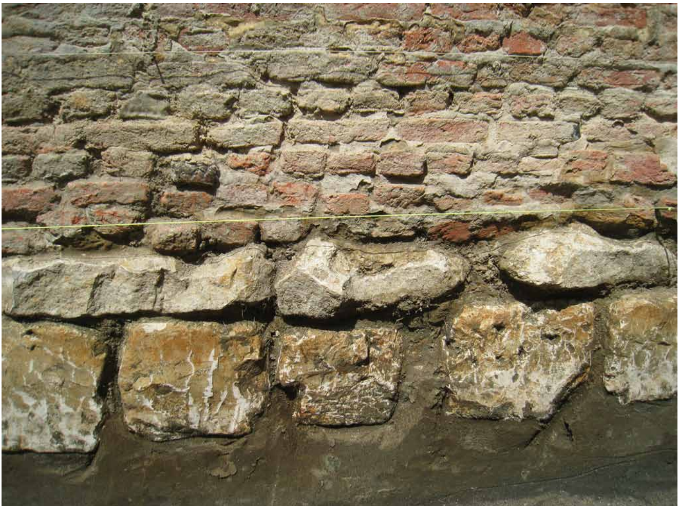
Fig. 7. Onderfundering parementzijde van face 1: kalkzandstenen vervangen een laag krijtsteenblokken
