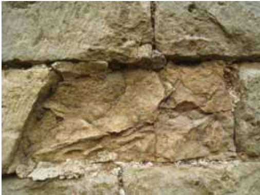
Fig. 52. Mogelijk stukgeschoten parementstenen
