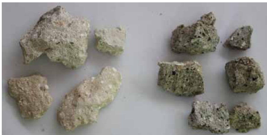
Fig. 59. Metselmortels met verschillende samenstelling: links witte kalkmortel en rechts grauwgrijze trasmortel, face 1
