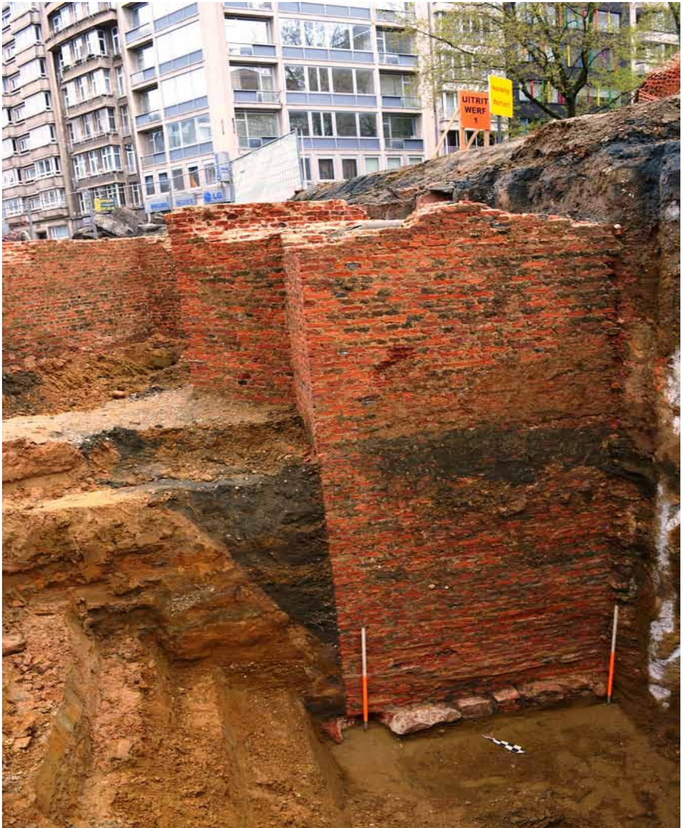
Fig. 10. De centrale steunbeer 7 met fundering en doorsnede van de bouwsleuf. Deze werd volledig vrij gelegd tot op het funderingsniveau. Het geheel was bewaard over een hoogte van 4,43m. De onregelmatige fundering, opgebouwd met natuursteen, baksteen en mortel, zette 1,70m hoger aan dan de onderzijde van de krijtbasis van de hoofdmuur van het bastion (cf. ook Minsaer 2009, 162 voor een vergelijkbare situatie bij het Keizersbastion).
