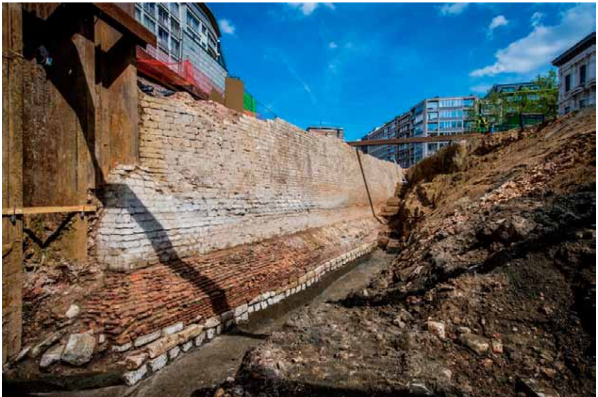
Fig. 5. De zuidelijke voorzijde met typische piramidale hoek op de bastiondraai. De muur steunde op een uitspringend fundament van in totaal 1,62 m hoog (baksteenbasis en onderliggende krijtvoet). De parementstenen van de muur volgden een hellingsgraad van het bolwerk (ongeveer 9°) en de ronding van de bastiondraai (oreillon). (foto Frederik Beyens)
