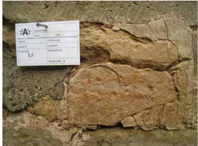
Fig. 57. Herstelling aan parementstenen met donkergrijze trasmortel; rechtsboven en linksonder is de oorspronkelijke witgrijze kalkmortel nog aanwezig, face 1.
