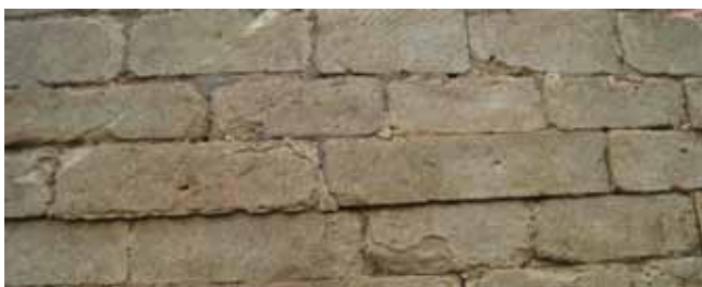
Fig. 56. Parementstenen met witbeige mortel, face 1
