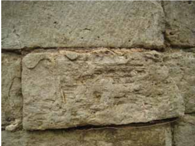
Fig. 42. Brusseliaanse steen, Gobertange variant, waarin uitgeëtste kalklaminaties en met zand opgevulde graafgangen (23 x 10 cm)
