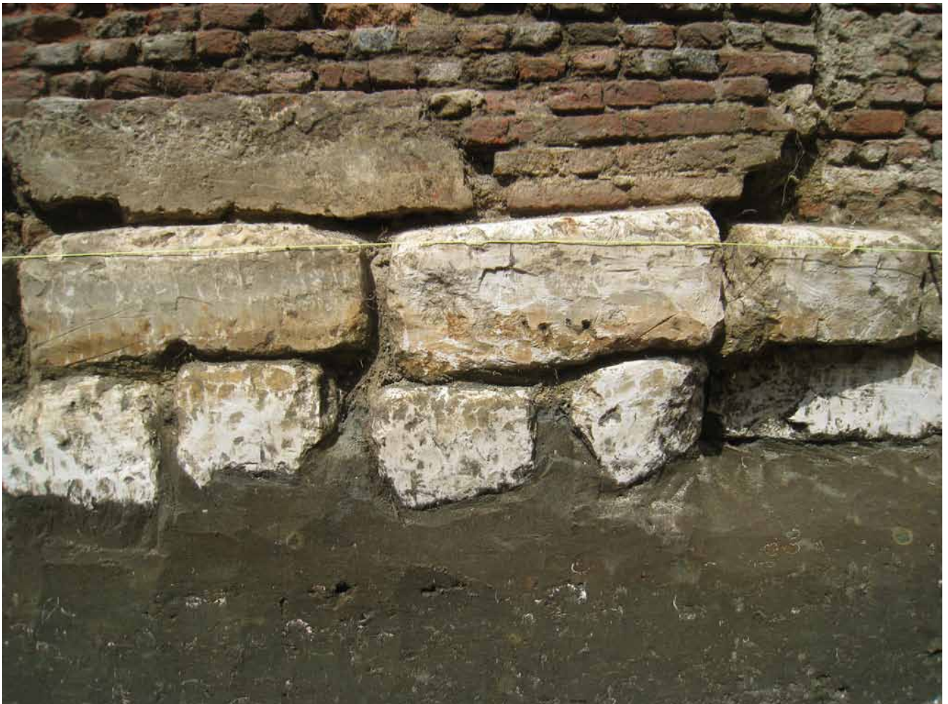
Fig. 6. Onderfundering face 1, krijtsteen boven op de zwarte laag
