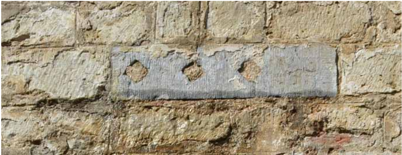
Fig. 19. Een onderdorpel of latei in blauwe hardsteen werd mee verwerkt in het parement en is voorzien van frijnslag en randslag, aangebracht met een ceseel.
