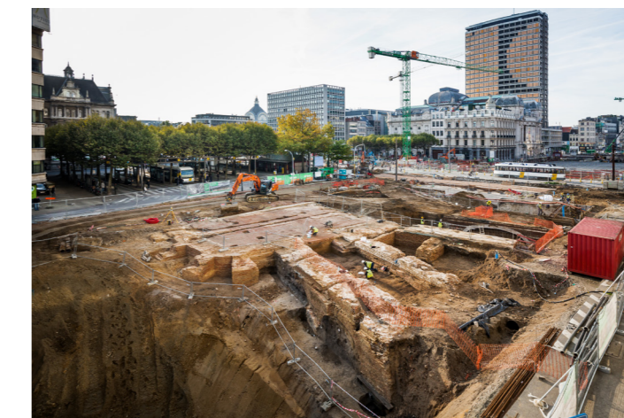
Kipdorpbastion en -brug tijdens de opgravingswerken in 2017
