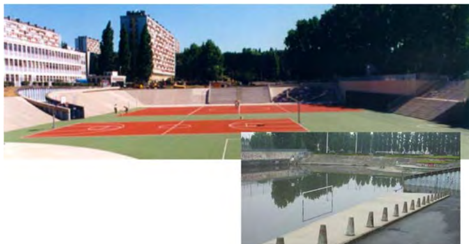
Figuur 10-7: Regenwaterberging in verlaagde sportterreinen
