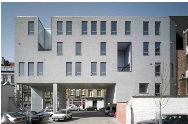
Sociale woningen bovenop Colruyt parking, Jeruzalemstraat Schaarbeek, BOB361 architecten, 2005.
