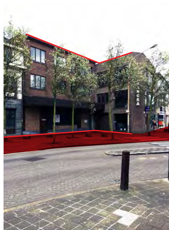
Nood aan verbetering inrichting publieke ruimte voor de gevel. Een open commerciële gevel op het gelijkvloers is wenselijk bij een nieuwbouw of herbestemming van het gebouw.
