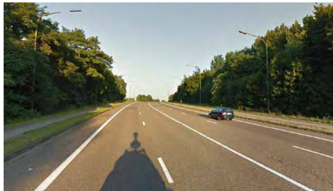
Zicht op de bestaande overgedimensioneerde Transcontinentaalbrug.
