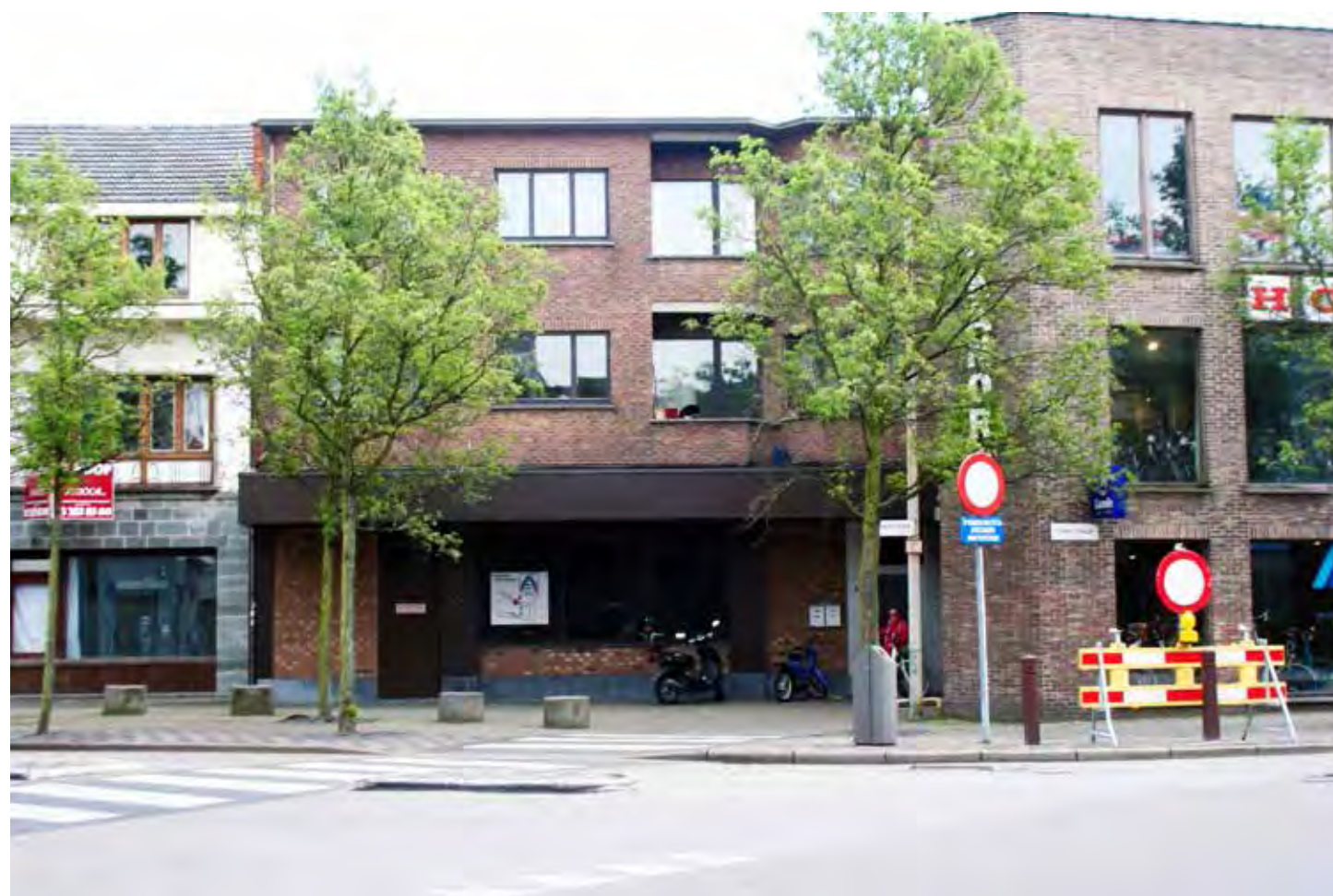
Huidige gesloten gevel gelijkvloers Driehoekstraat.
