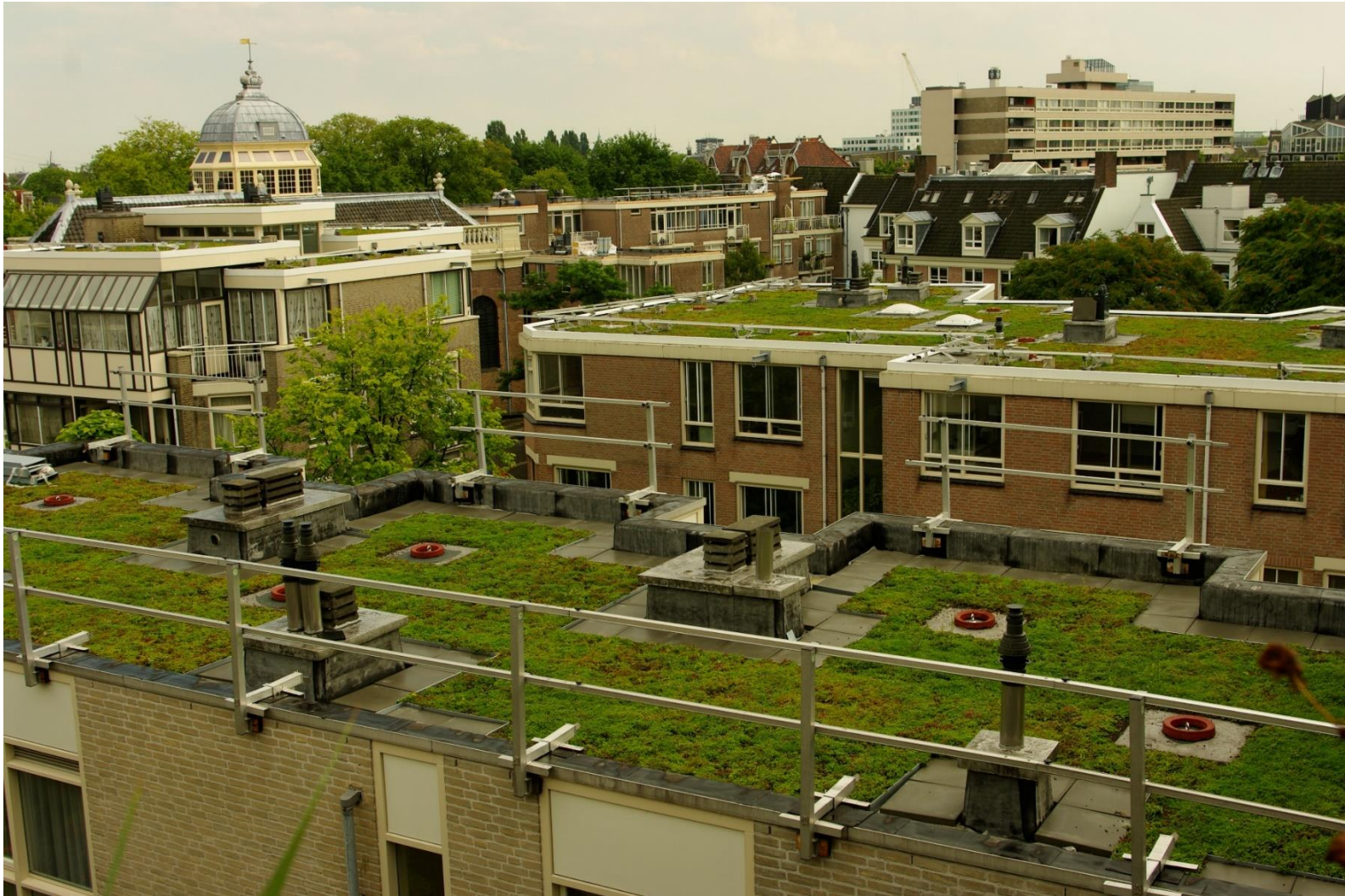
Figuur 3: In een robuuste stad wordt water op verschillende niveaus opgevangen en vertraagd afgevoerd. Groendaken kunnen tot 85% van het volume van een zomerse storm absorberen en verdampen in de uren na de bui. Ook in de winter zorgen ze voor een sterke vertraging van de afstroming. (foto: Picasdre – Creative Commons)
