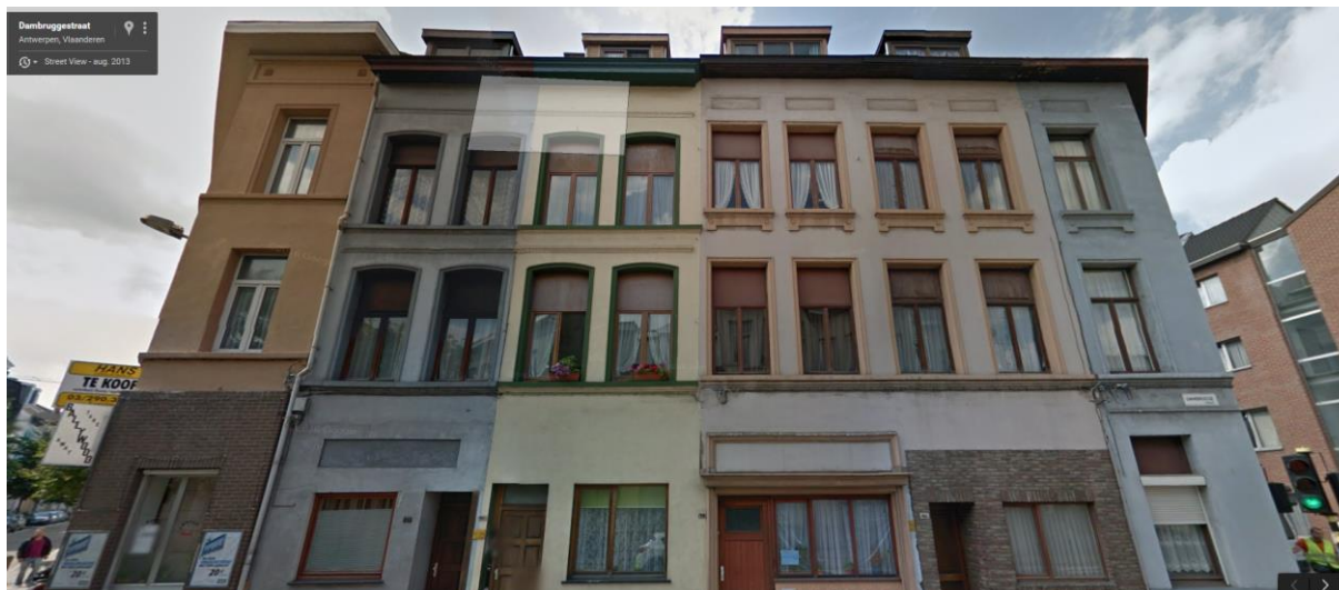
Figuur 35: Dambruggestraat - Zes wooneenheden, één zichtbare dakafvoer.
