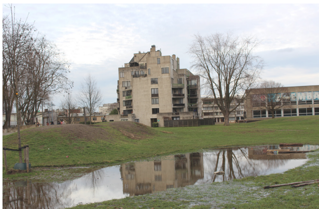
BESTAANDE TOESTAND - WATERPROBLEMATIEK AAN DE ARENAWEIDE
