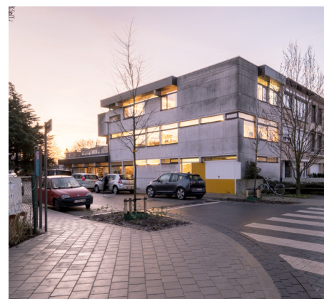
KANTOREN BULK ARCHITECTEN, WOUTERS & MOSTIEN, 1970, DEURNE
