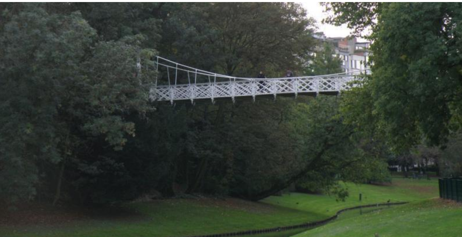
Afbeelding 20, hangbrug, gezien vanuit de zuidoostzijde van het park, in westelijke richting.
