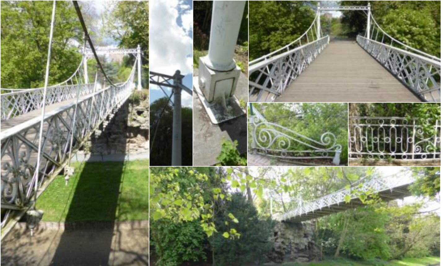
Afbeelding 2.14, beelden van de hangbrug. Detailweergaven van de staat van onderhoud zijn opgenomen in bijlage 3.
