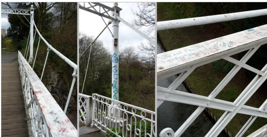
Foto's roestvorming graffiti, stiftresten, stickers en graveringen.
