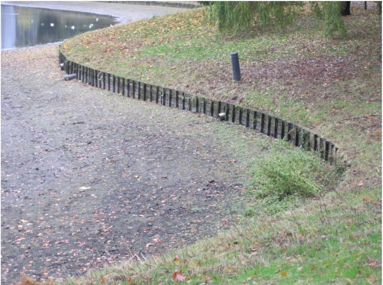
Foto 4-1. Regenwaterafvoer van de kolken op de verharde paden rond de vijver
