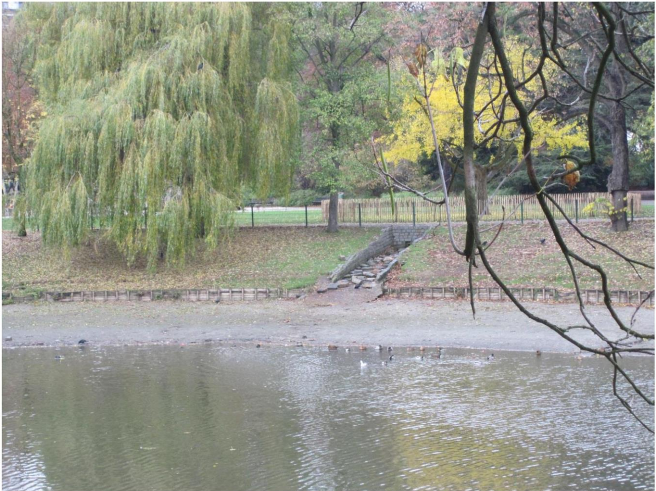
Foto 1-1. Trapvormige infrastructuur aan de Stadsvijver, voorheen gebruikt als inlaat voor de grondwatertoevoer, afkomstig van het drainagesysteem rond het voormalige Switel-hotel
