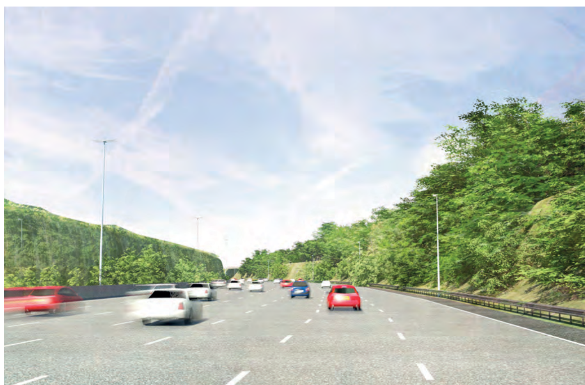
Te vermijden situatie ter hoogte van Berchembrug
