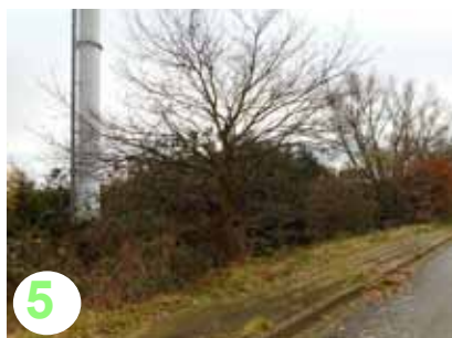
5 Klimboom op talud van brug
