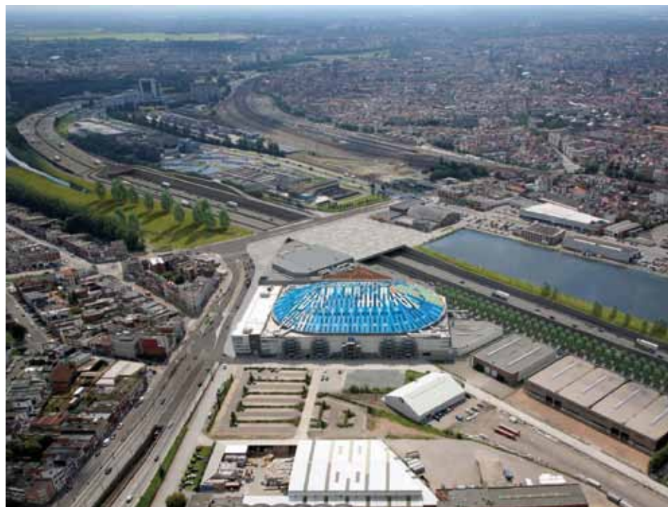
Tunnel Schijnpoort © TV SAM
