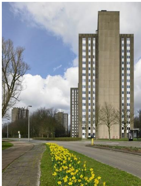
Figuur 3-7 Vinkevelen (voor de renovatie)
