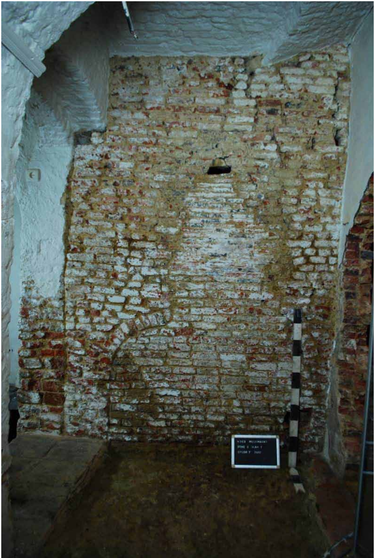
Figuur 21. De dichtgemaakte zuidzijde van oven S7
