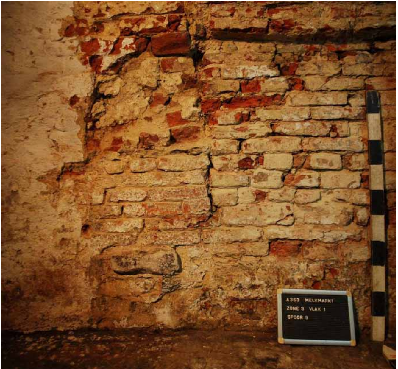
Figuur 14. Detailopname van scheimuur S9
