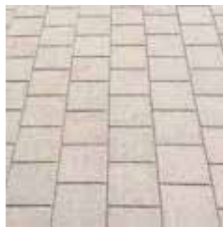
Standaard betontegels voetpad
