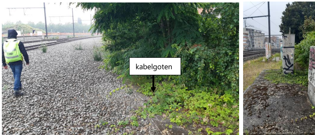
Afbeelding 7.10 Opleidingsspoor met in de binnenbocht kabelgoten, kasten en vegetatie
