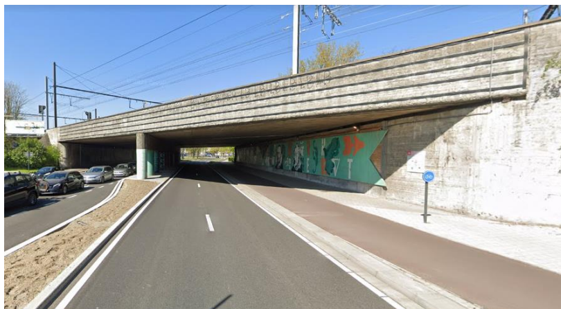
Afbeelding 7.7 Spoorviaduct Plantin en Moretuslei
