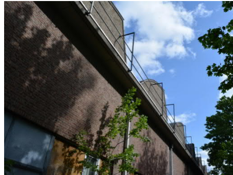
8. zicht op loods vanuit het ingesloten groene gebied
