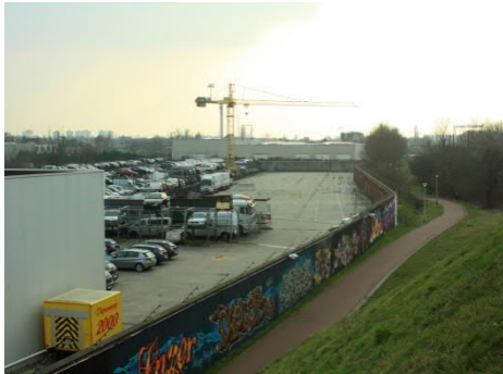
13. zicht op de terreinen van Depannage 2000 en het Jef Van Linden fietspad en talud Herenpolderbrug
