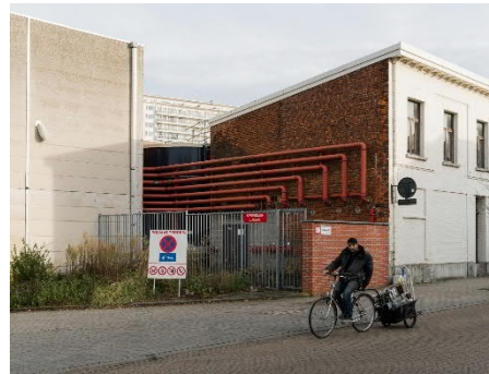
2. zicht op Crown Packaging en woningen in de Krugerstraat
