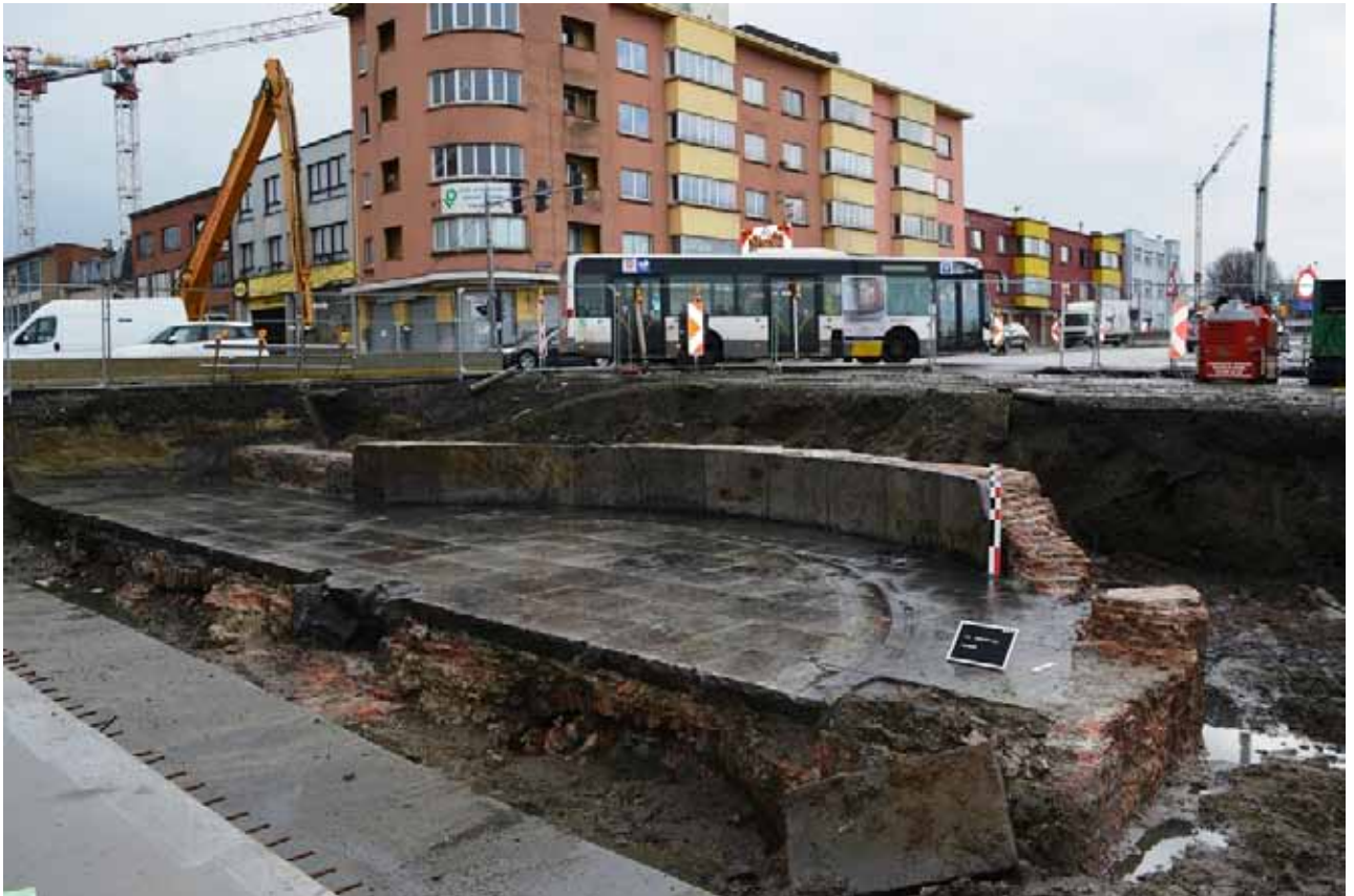
Basis van het brugdek met natuurstenen plaveien en uitgehouwen draaicirkel van de oorspronkelijke brug
