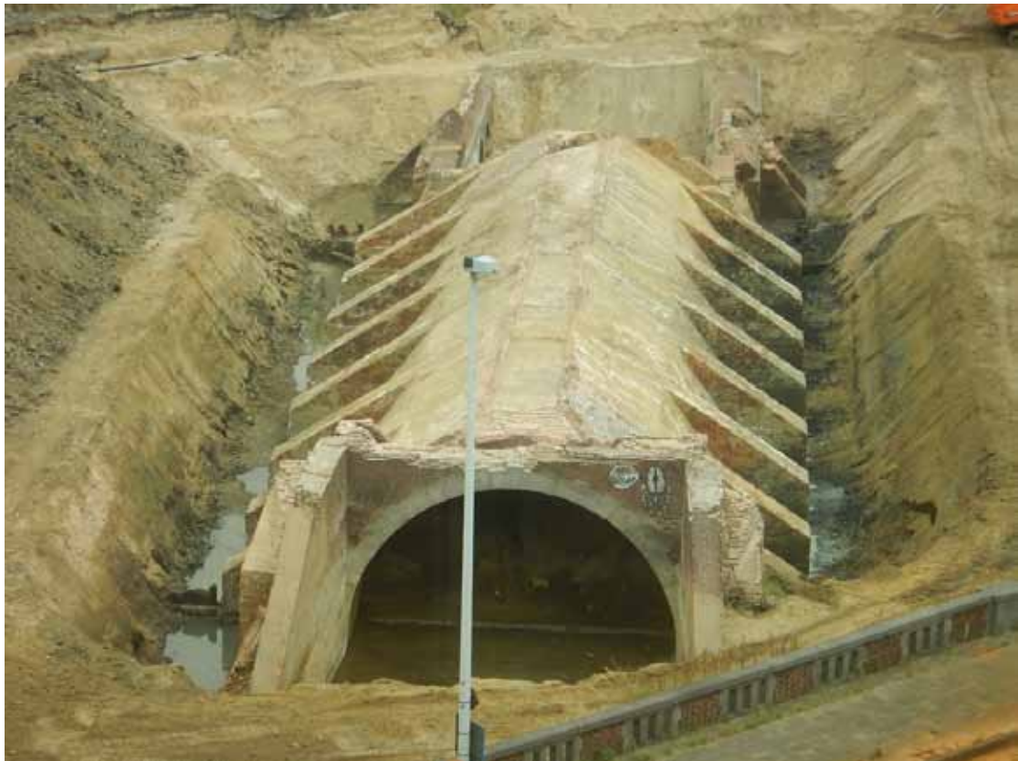
Algemeen overzicht van het volledig vrijgelegde Sas van de Schijn
