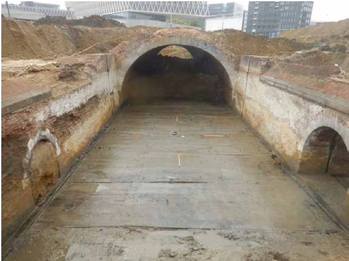
Vrijgelegde waterleiding door de gracht
