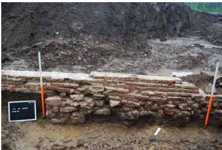
Ondiepe fundering met gerecycleerd materiaal, waarschijnlijk van een houtconstructie
