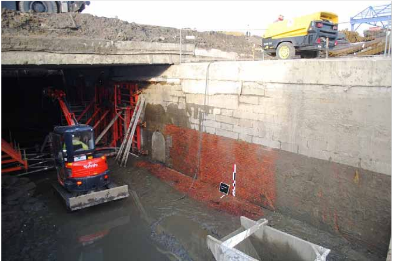
Noordwestelijke sluiswand, bovenaan afgekleed met natuursteen, onderaan uitgewerkt in baksteenmetselwerk
