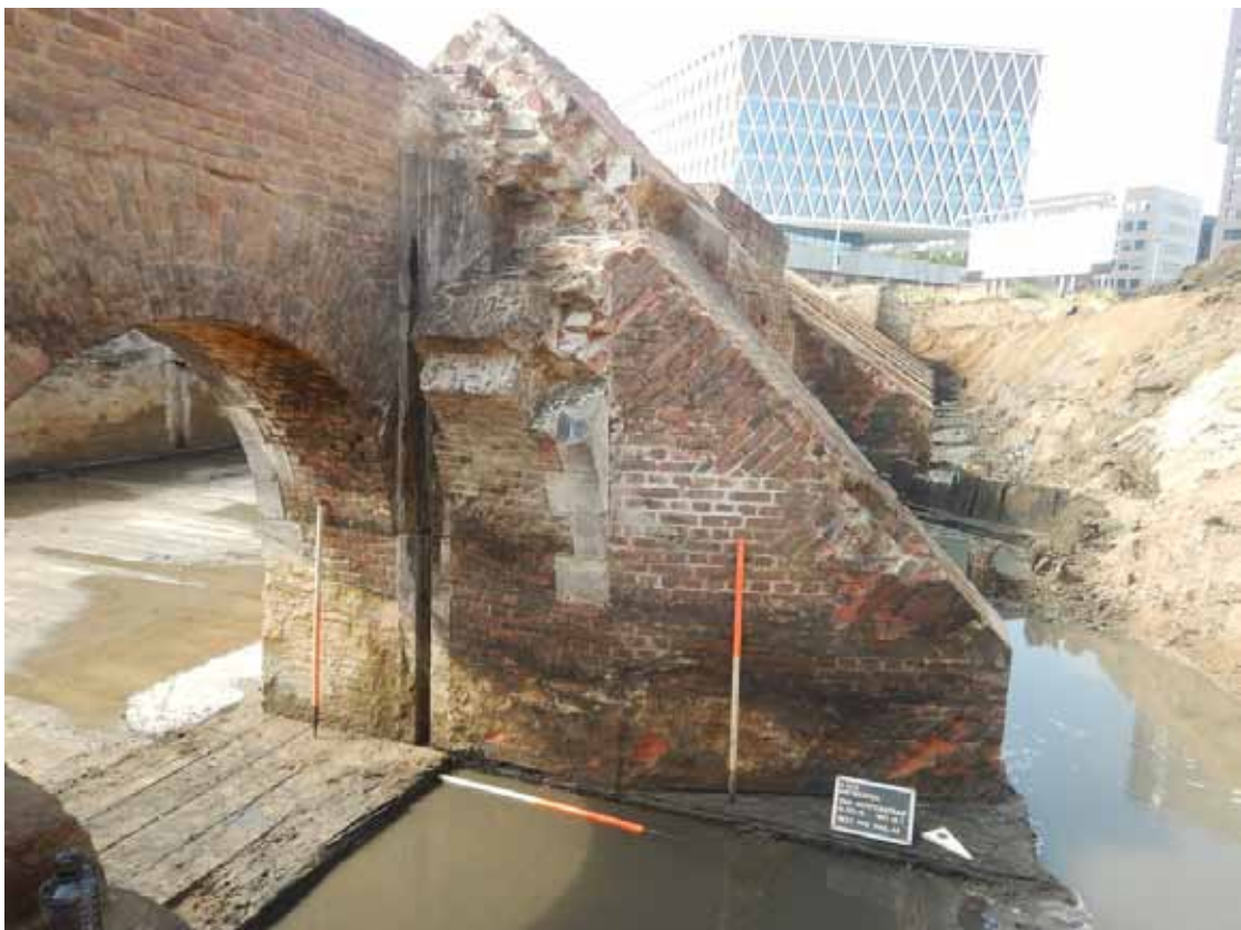
Buitenaanzicht (zijkant) sluisopening in open kanaal (noordwestzijde)
