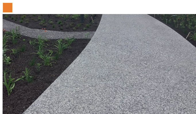
FIGUUR 15 UITGEWASSEN BETON (REFERENTIE ZNA)
