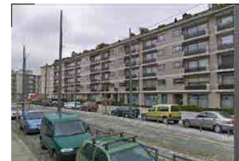
Appartementen langs Dascottelei, Deurne
