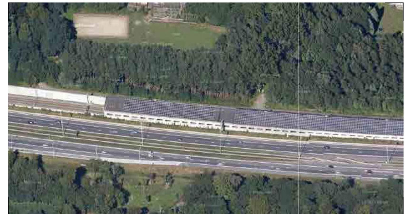
Tgv-infrastructuur langs E19 door het Peelsbos
