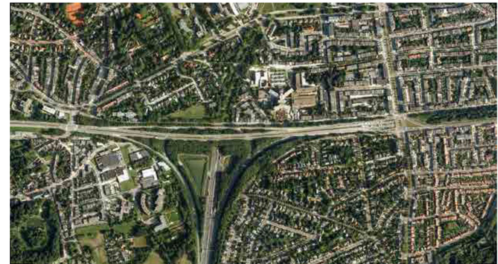
E19 verdwijnt onder het Middelheimpark in de Chapeybechtstunnel
