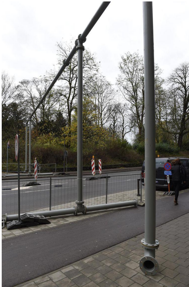
Figuur 10: tijdelijke leidingenbrug bij retourbemaling naar het stadspark
