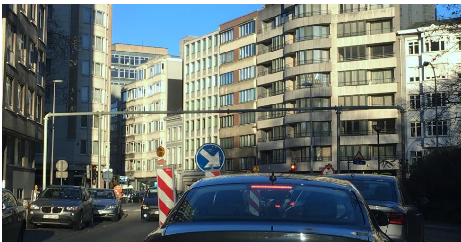
Figuur 9: tijdelijke leidingenbrug bij retourbemaling naar het stadspark
