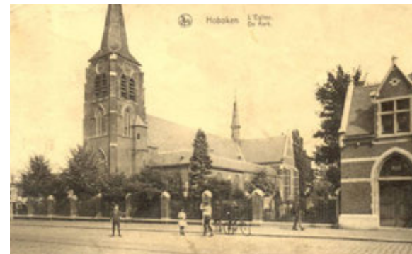
Dit historische beeldje toont de kerk met een afgebakende groene kerktuin rondom. De kerk is goed zichtbaar vanaf de Kioskplaats.
