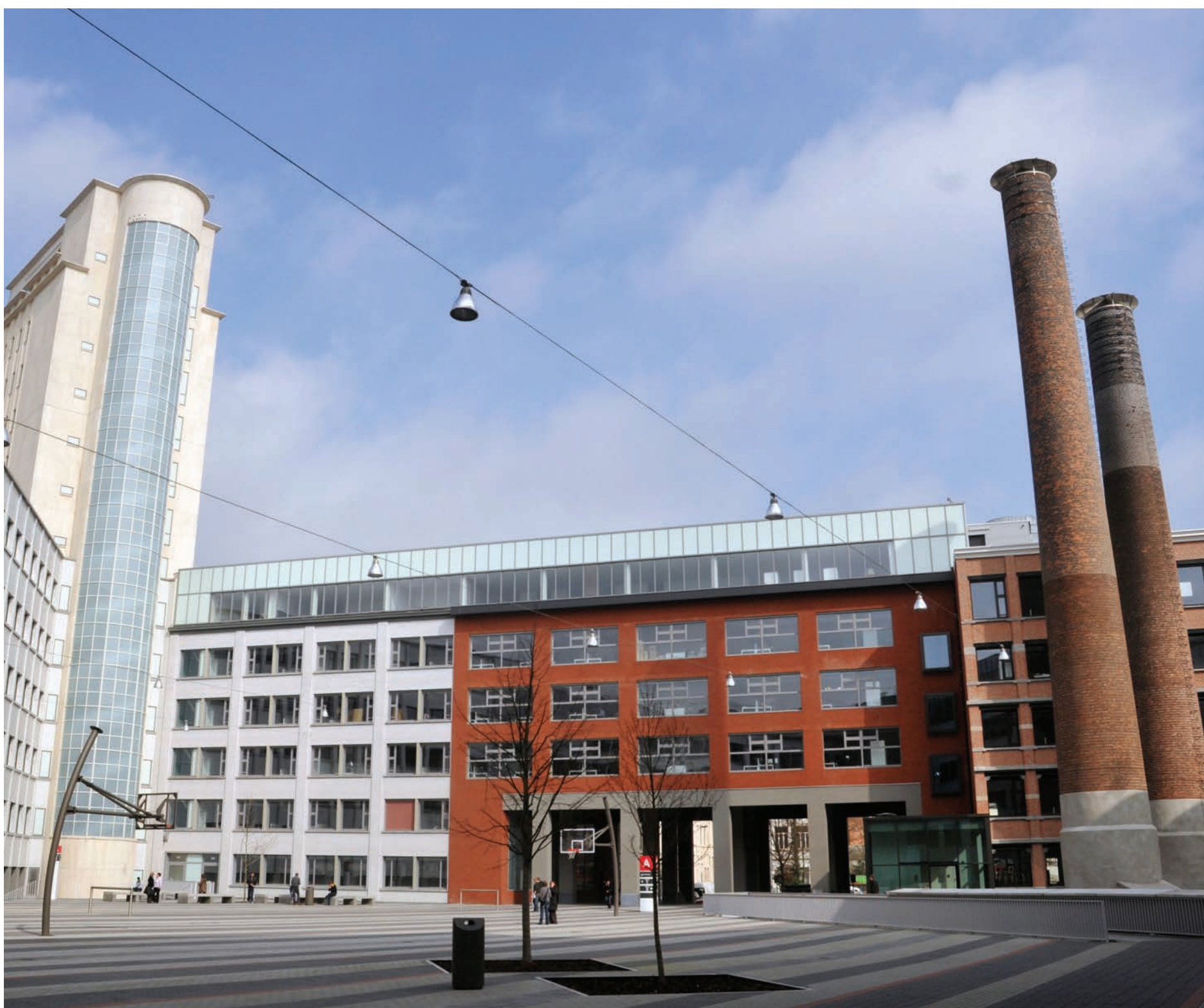
Beeld van de huidige situatie binnenplein 'Den Bell'
