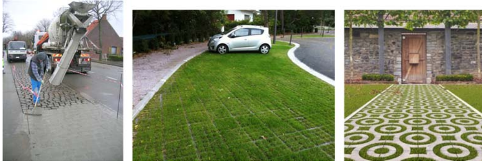
Figuur 17: Waterdoorlatende parkeerstroken (nu nog vaak gecementeerd) en groene voegen of grasdallen als mogelijkheden voor waterdoorlatende verharding
