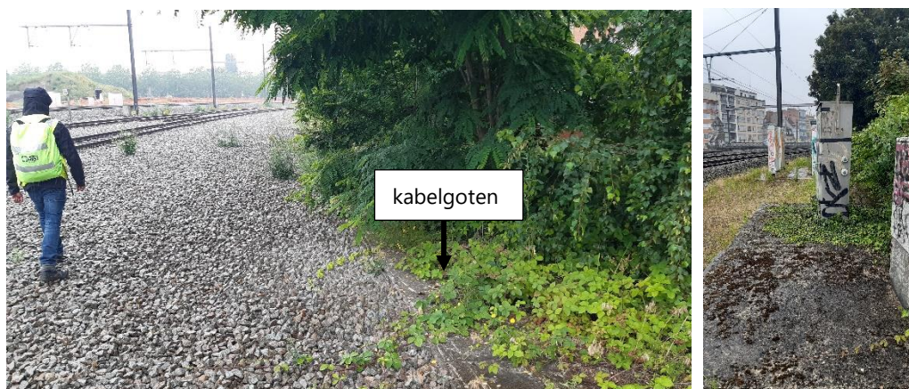
Afbeelding 3.11 Opleidingsspoor met in de binnenbocht kabelgoten, kasten en vegetatie
