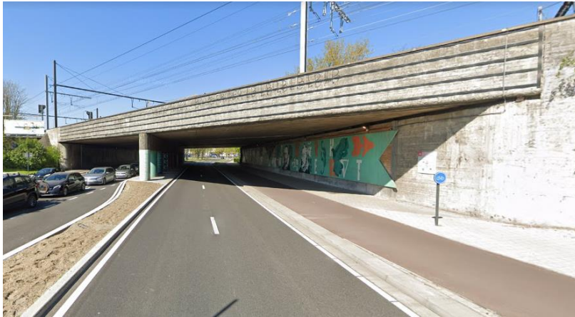
Afbeelding 3.7 Spoorviaduct Plantin en Moretuslei
