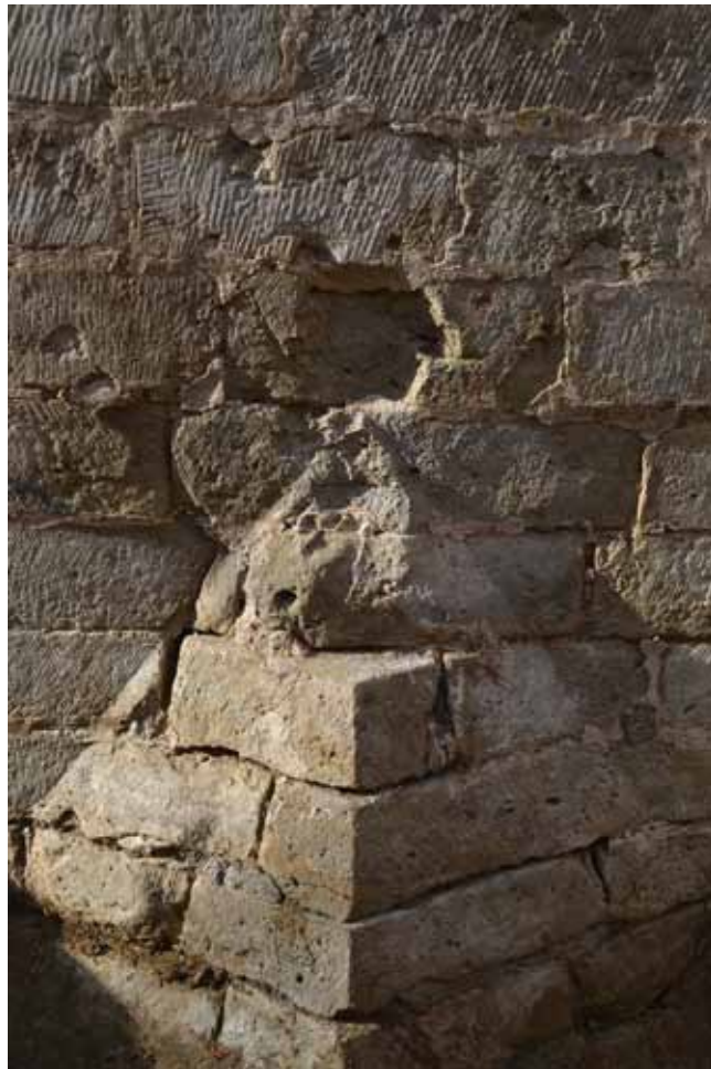
Figuur 5. Zicht op de piramide van de bastionpunt met negatief spoor van de bol
