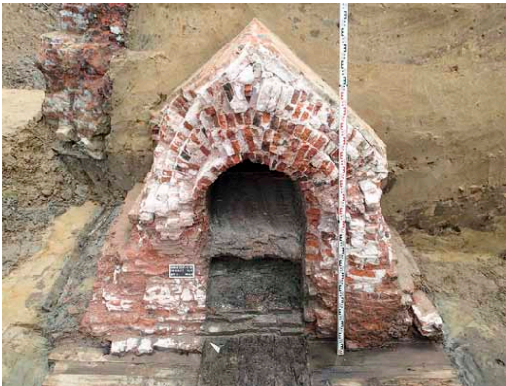
Figuur 2. De binnenruimte van het kanaal was hoog genoeg om onderhoudswerken toe te laten. (© Fodio)
