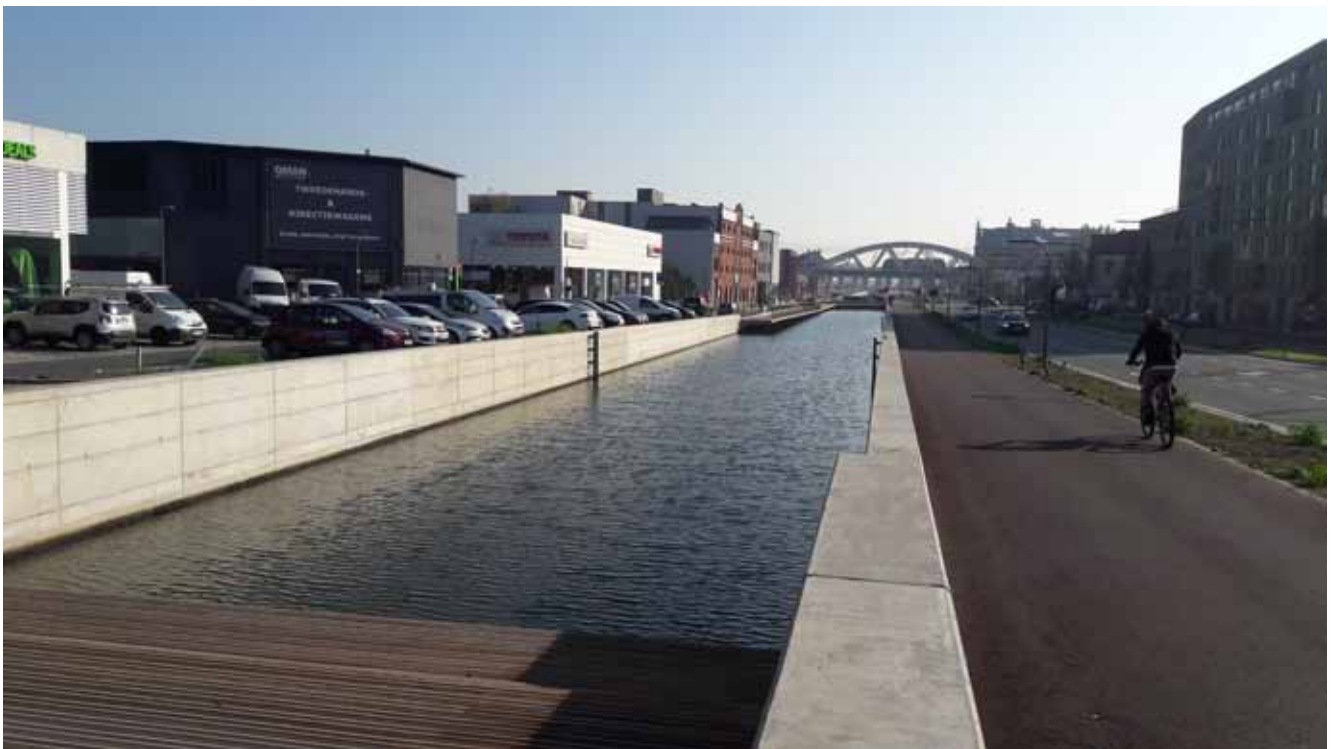
Figuur 4. Nieuwe aanleg van de IJzerlaan in 2017
