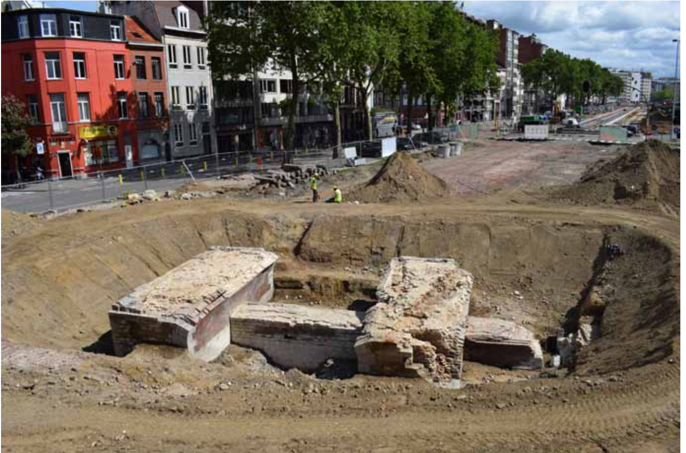
Figuur 2. De brugpijlers van de Rodepoortbrug en de keermuren van de houer ter hoogte van de Houwerstraat
