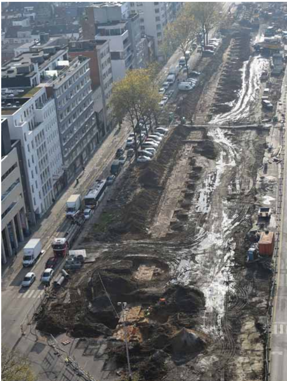
Figuur 1. Stadsmuur met steunberen op de Italiëlei
