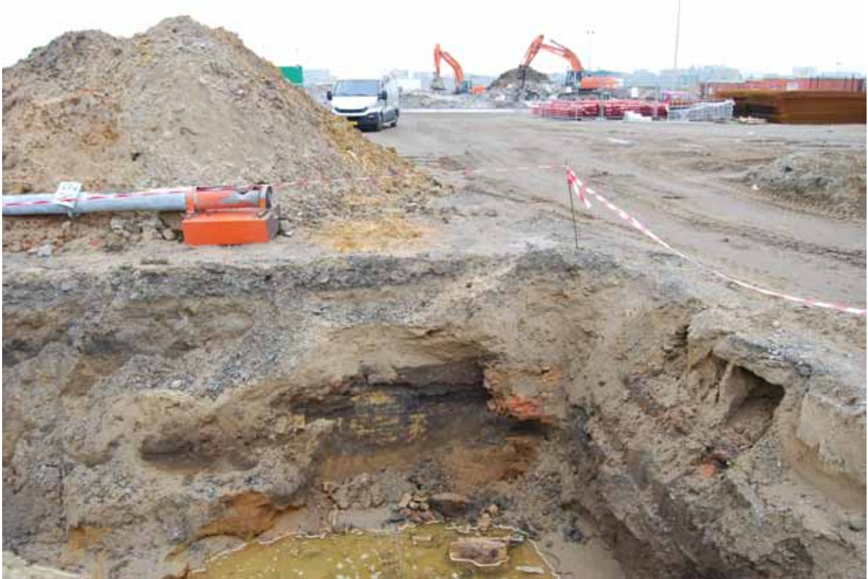
Figuur 1. Overzicht op de bouwput waarin de menselijke beenderen gevonden waren
