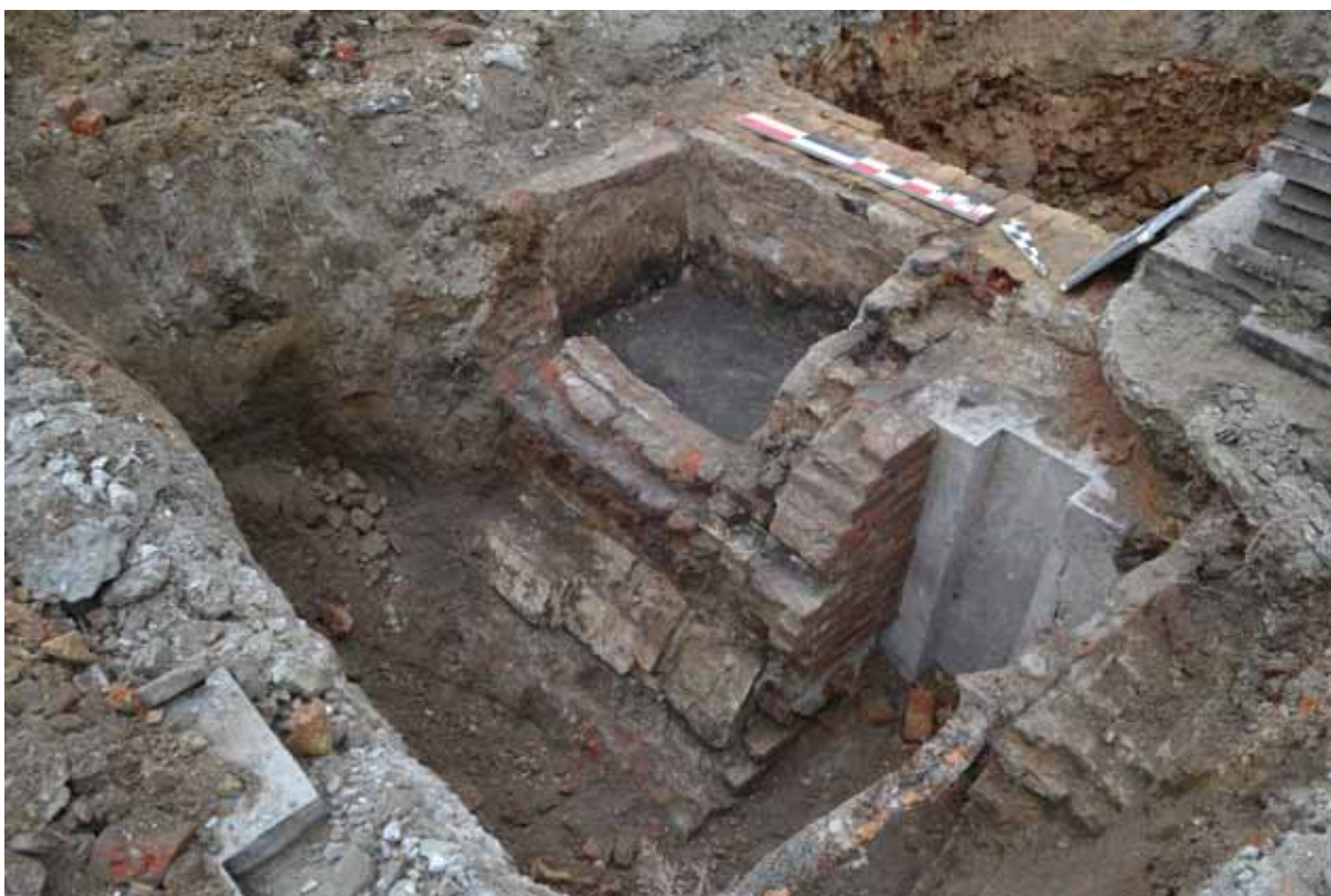
Figuur 2. Aanzet van de overwelfing van de vliet met rechts het element in blauwe hardsteen met gleuf voor de sluisdeur
