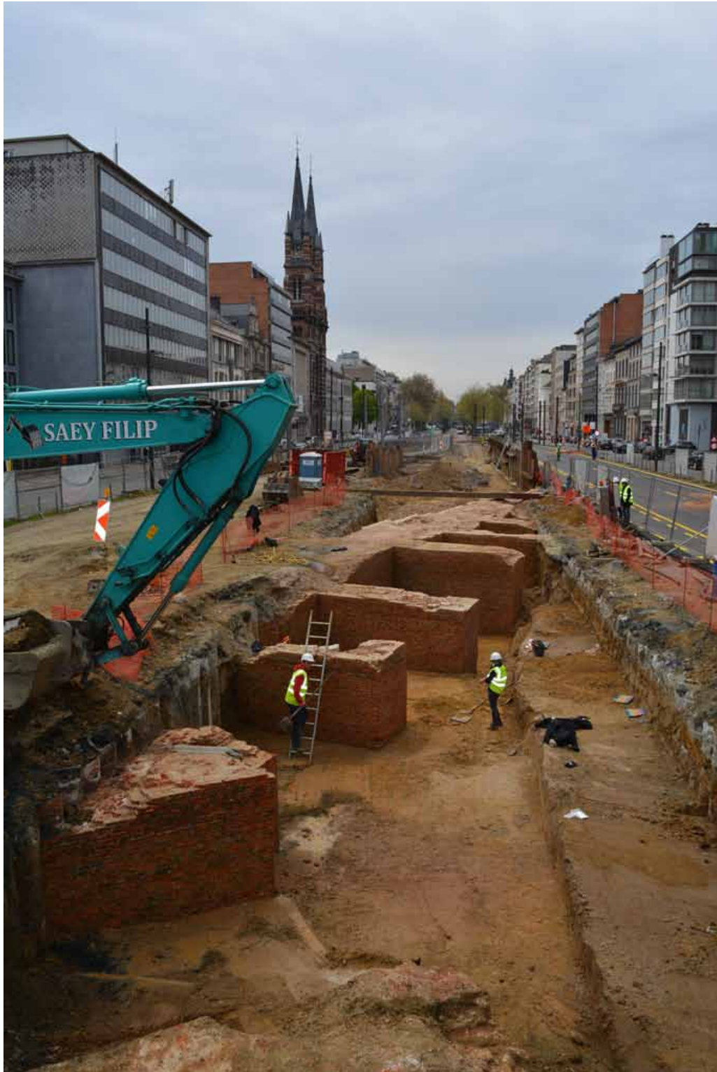
Figuur 2. Zicht op de binnenzijde van het bastion met steunberen tussen de palenwand van de geplande tunnel
