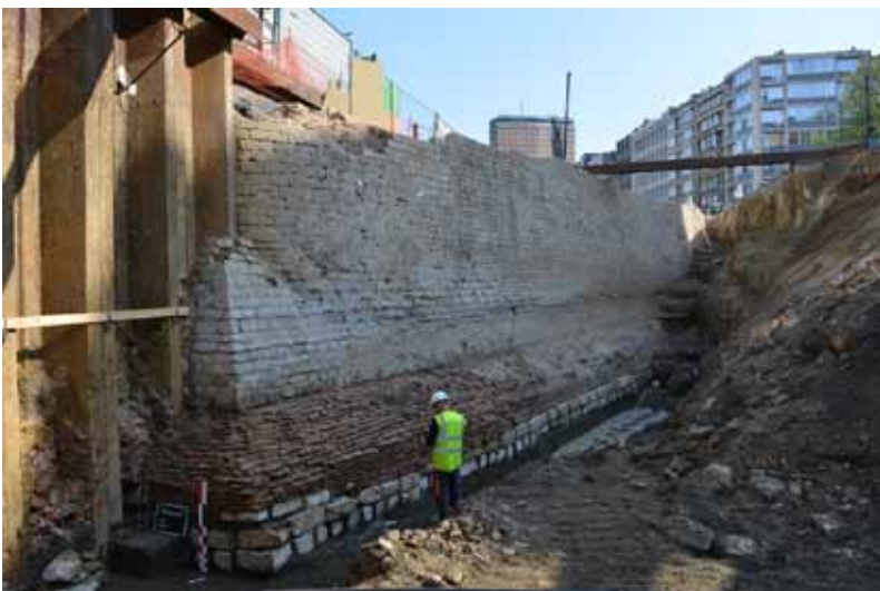
Figuur 1. De zuidelijke voorzijde (face) van het bastion met de funderingsvoet en het oreillon (oor) met piramide
