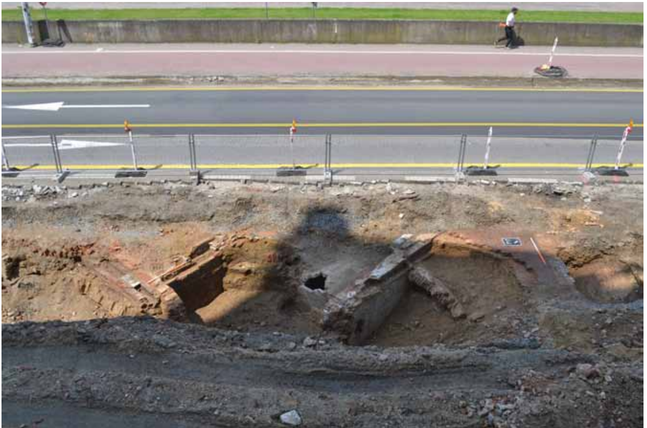
Figuur 2. Restanten van huizen van de Nieuwstad op het nieuwe rioleringstracé op de Van Meterenkaai
