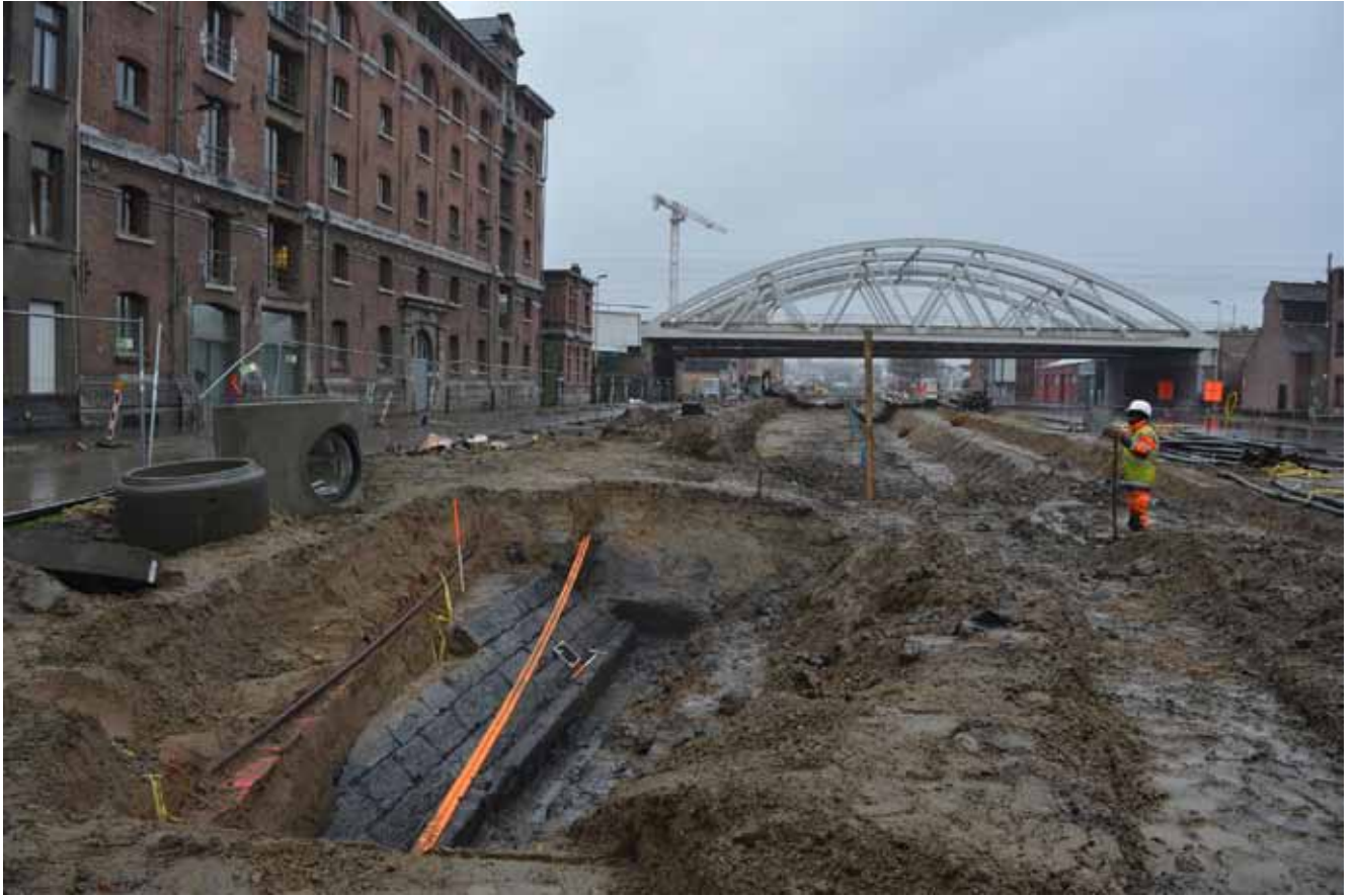
Figuur 3. Het kadetalud van de Kempische Vaart (zuidzijde IJzerlaan)
