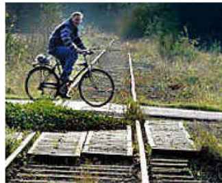
betonplaten als ruggegraat van de rustplaatsen
