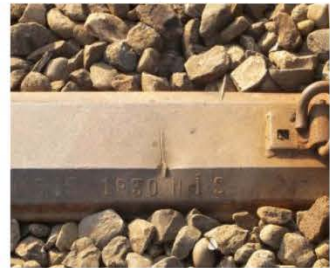
talud afwerken met spoorballast (breuksteen)
