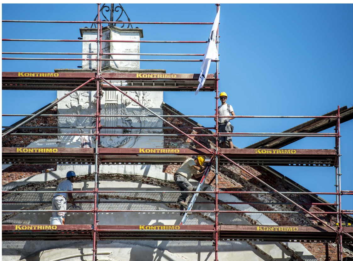
restauratie van de voorgevel
