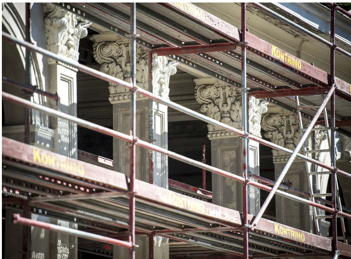
restauratie van de voorgevel
