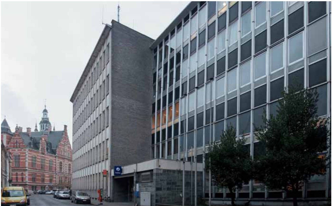
het gebouw van het administratief centrum en het politiegebouw Procesnota Moorkensplein en omgeving | mei 2015
