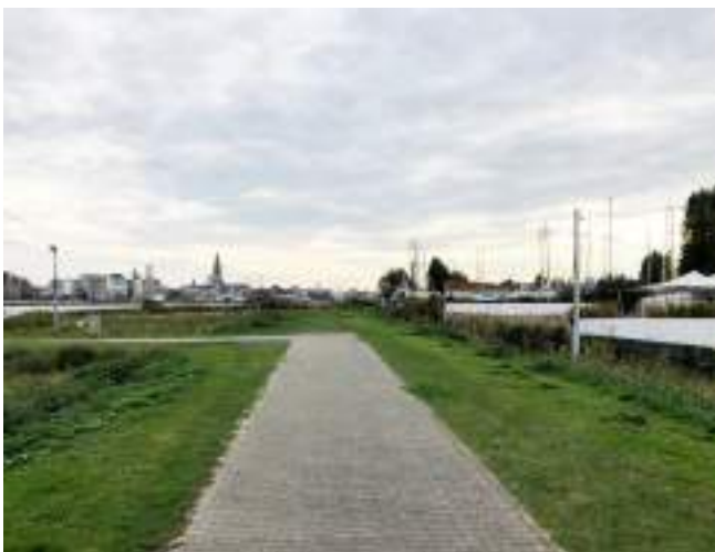
Onderbroken dijkpad aan de jachthaven
