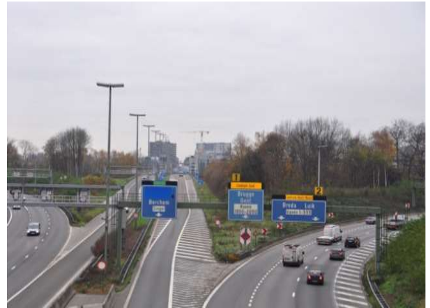
Op- en afritten complex E19-R1
