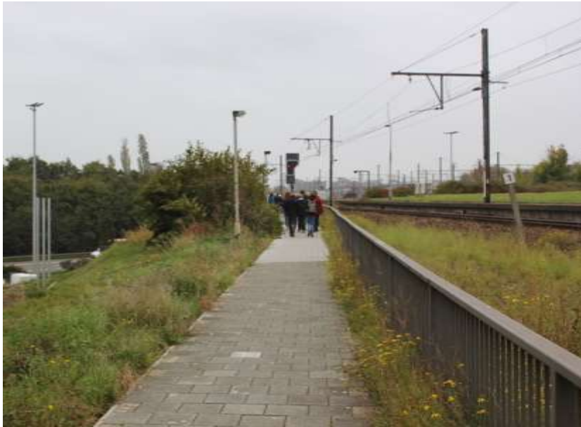
voetpad langs de spoorwegbrug
