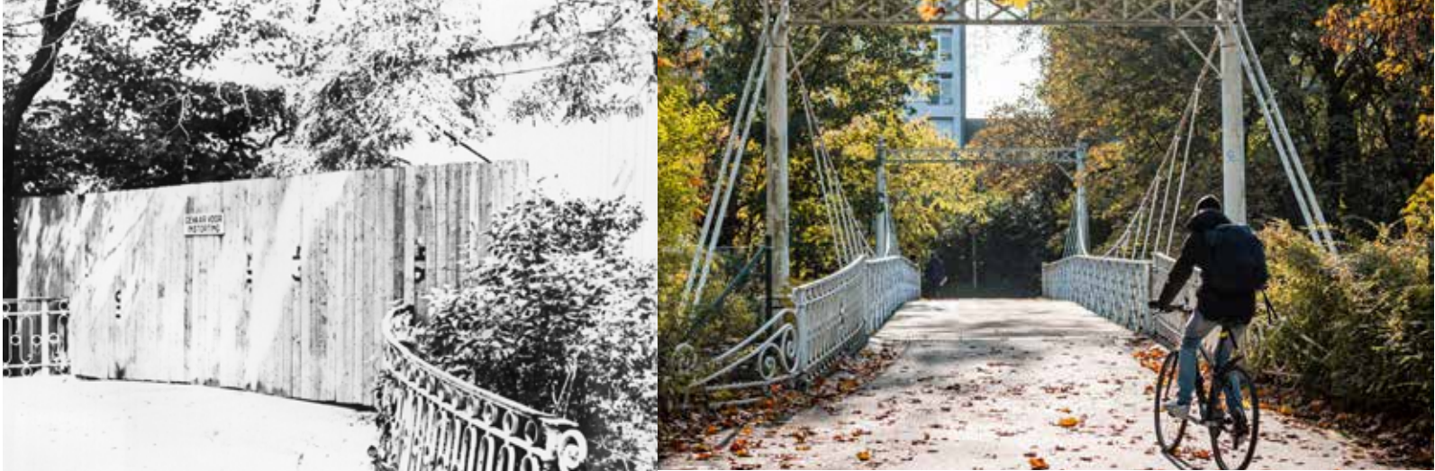
In 1972 werden er reeds werkzaamheden aan de brug uitgevoerd. In 2020 krijgt ze opnieuw een grondige restauratie.
