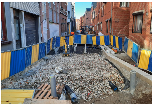
Waterbergende wegfundering, Lange Riddersstraat
