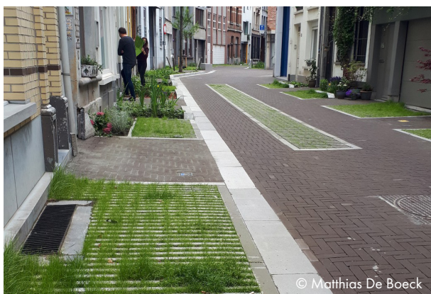
Grasbetontegels als halfverharding om de toegankelijkheid toegangen én brandweer te waarborgen - Tuinstraat Lange Riddersstraat, Antwerpen
