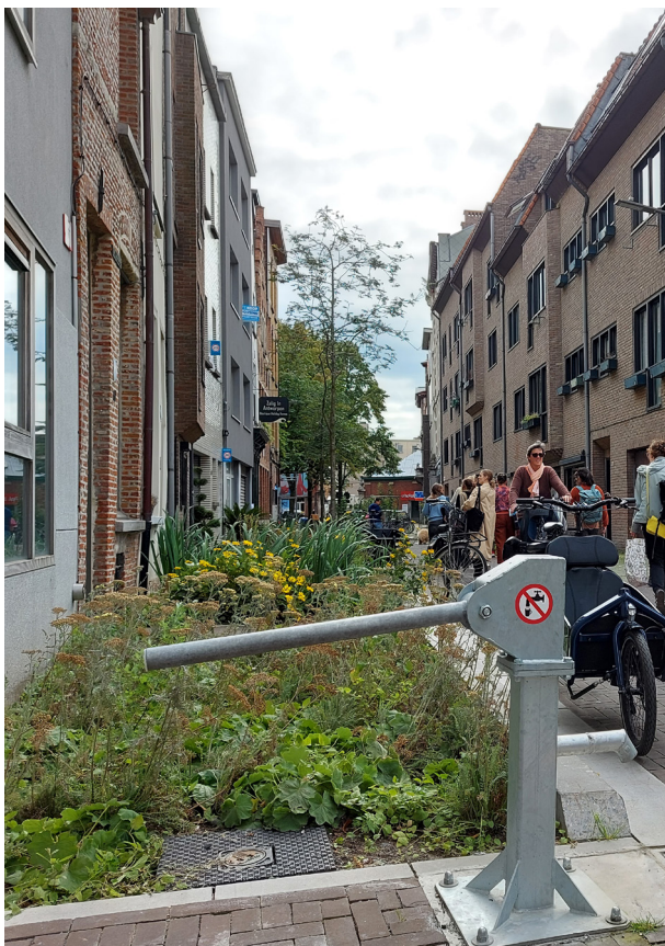
Collectieve regenwaterput Lange Riddersstraat
