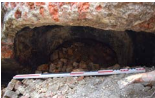
Figuur 72. Spoor 22 - detail van de doorgang onder het platte deel van het gewelf, volgestort met puin
