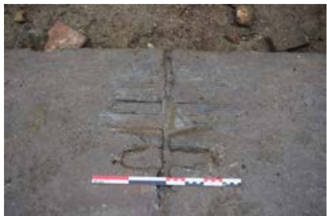
Figuur 57. Detail van de opvulling langs de zuidelijke zijde en een detail van de metalen doken
