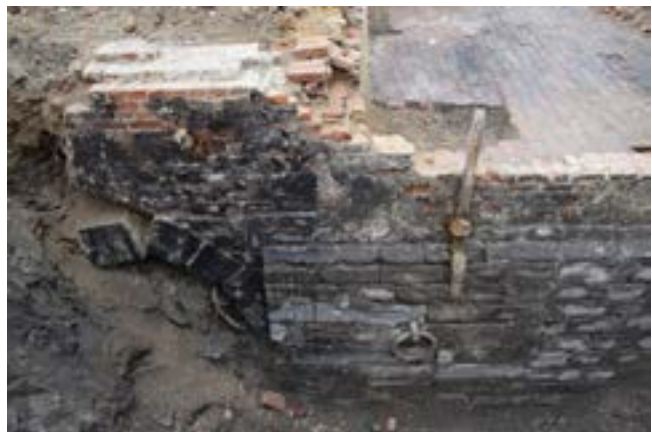
Figuur 35. Spoor 34 - detail van het metalen muuranker
