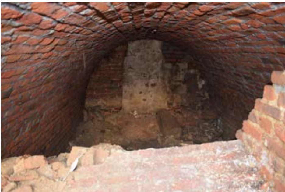
Figuur 45-B. Spoor 39 - de dichtgemetselde gewelfde doorgang
