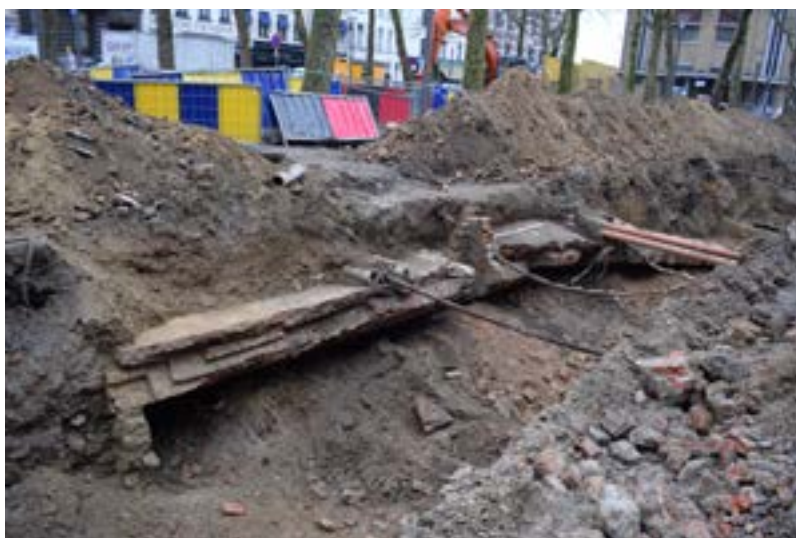
Figuur 68. Spoor 22 - aanzet van een keldergewelf
