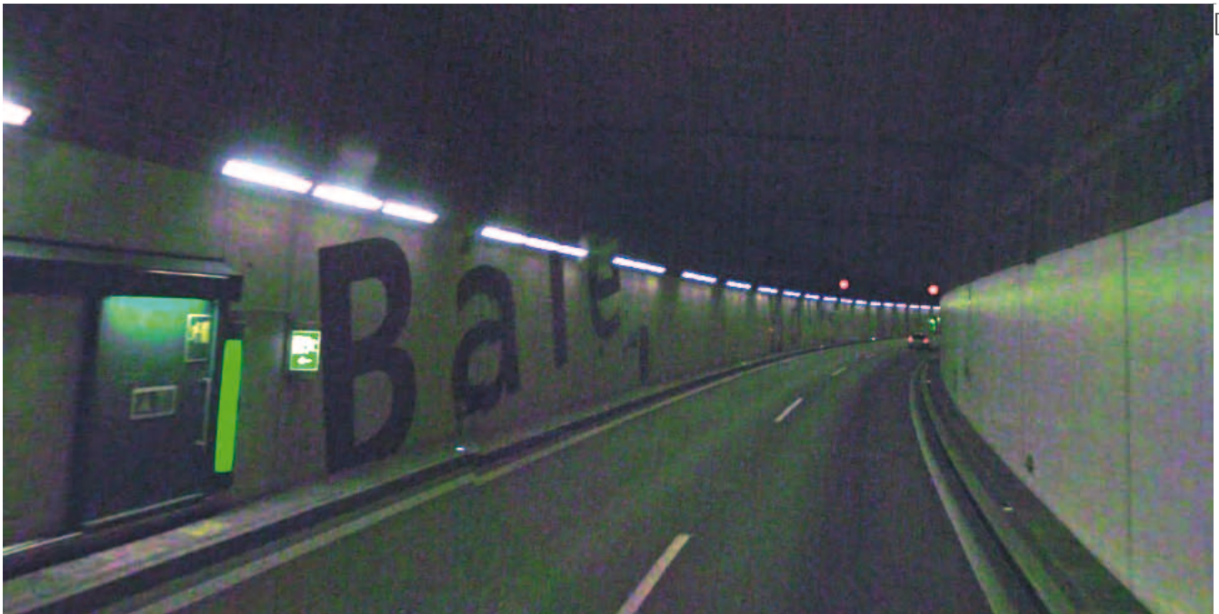
Beeld vanuit de tunnel Nordtangente in Basel Bron: Google Street view, 2011
