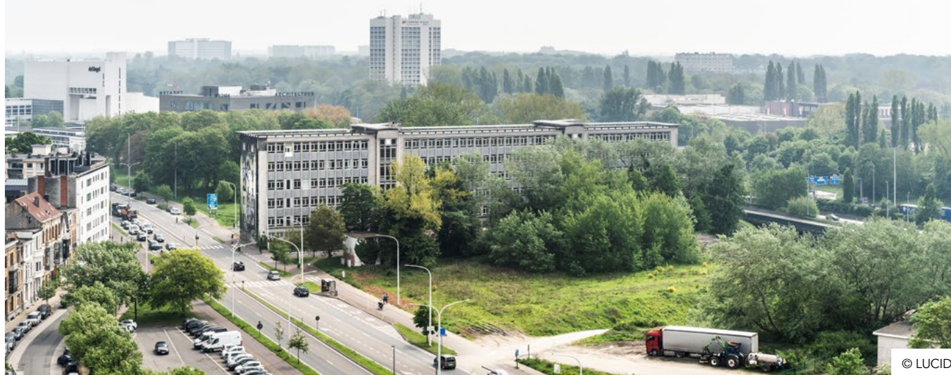
Het huidige dienstgebouw D33 centraal in beeld
