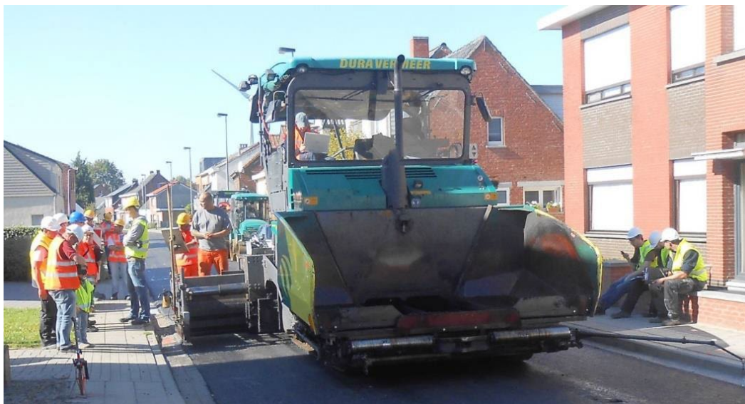
Figuur 3 - Aanleg proefvak met dunne geluidsreducerende deklaag in Zandvliet (© C. Vuye).
