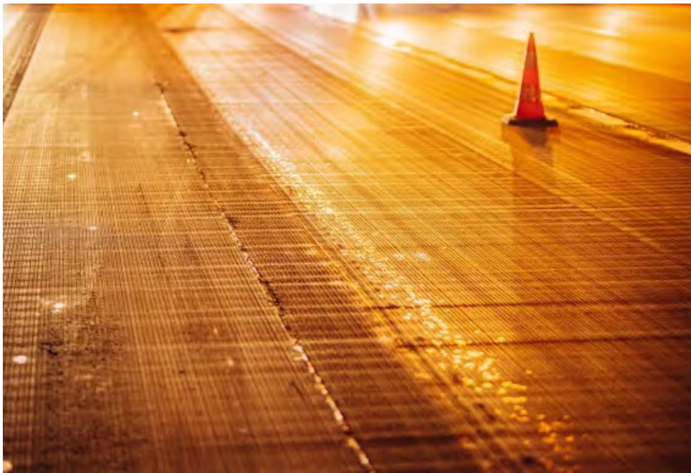
Figuur 19 - Next Generation Concrete Surface (NGCS) op de Antwerpse Ring (© AWV).
