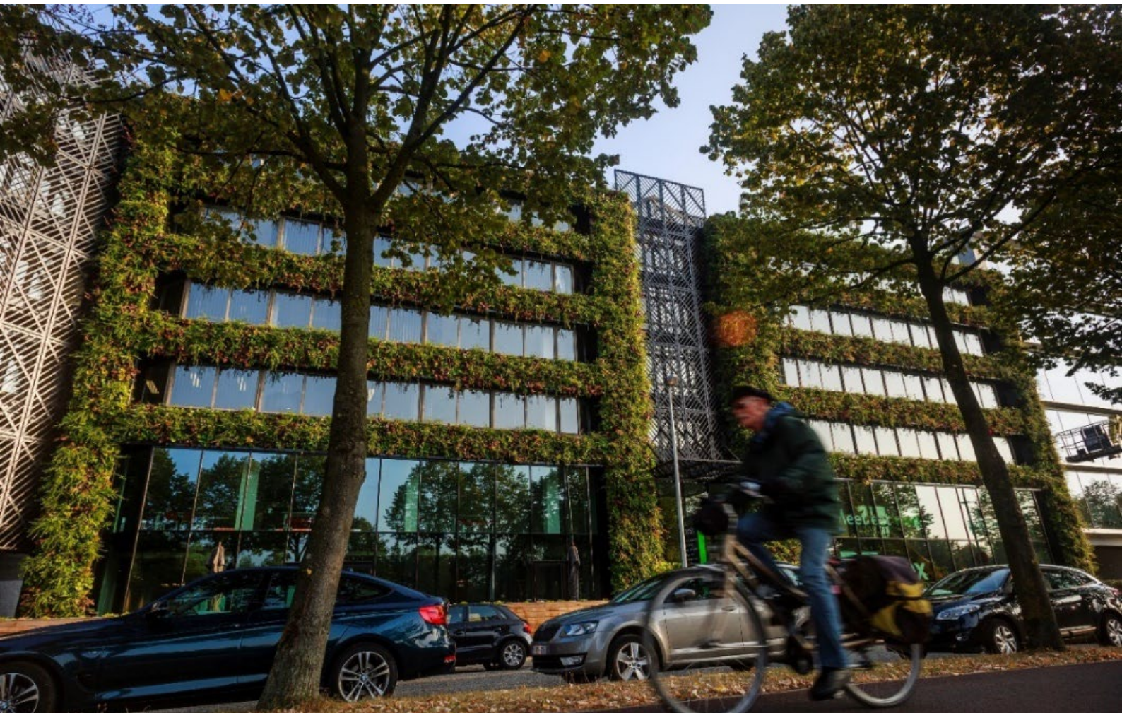
Figuur 22 - Groene gevel van Greenhouse Antwerp in Berchem: zachte materialen zoals groen met substraat reflecteren minder geluid dan harde materialen zoals glas, steen of metaal (© Victoriano Moreno).
