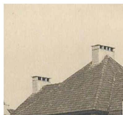
Historische schouw SC1
