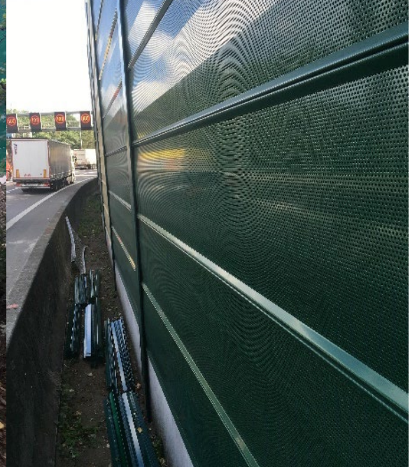
Figuur 4 - Geluidsabsorberend geluidsscherm langs de E313 en de Tuinwijk in Borgerhout (© Stad Antwerpen)
