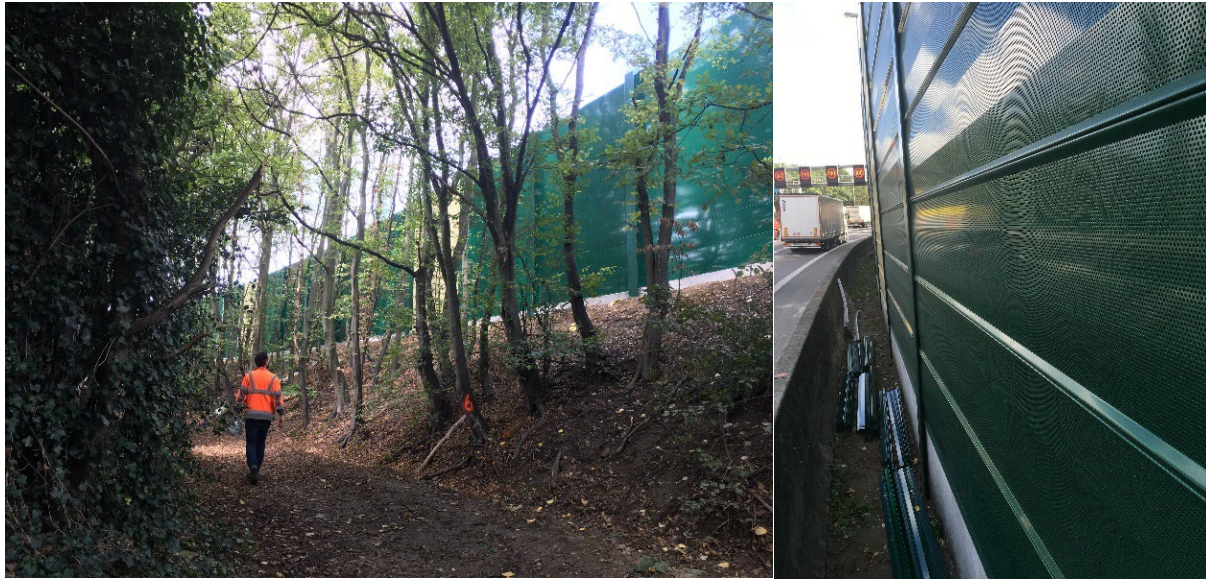
Figuur 4 - Geluidsabsorberend geluidsscherm langs de E313 en de Tuinwijk in Borgerhout (© Stad Antwerpen)
