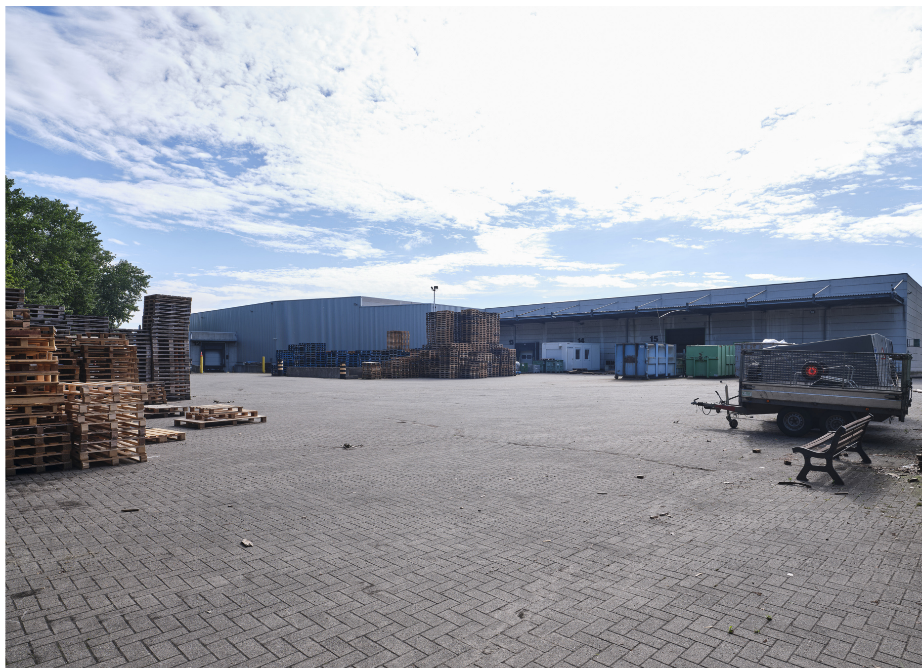
voor - bestaande achterkant
