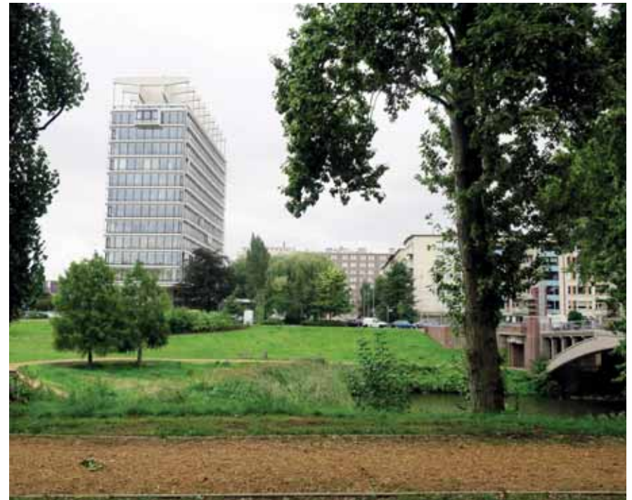
— De historische Brialmontomwalling is nog leesbaar in de ringzone dankzij Mastvest, met ernaast de BP-toren van Braem
