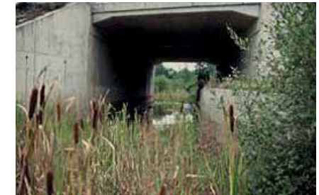
— Onverharde ongelijkvloerse strook bij ondertunneling infrastructuur
