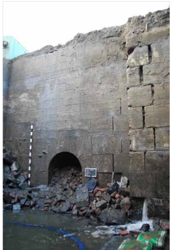
Opmeting van een zijwand van de monumentale sluis aan het Asiadok
