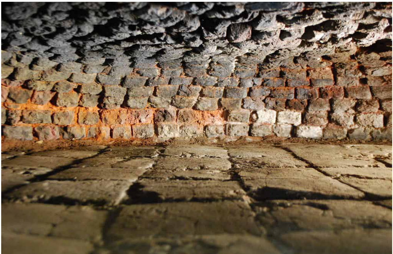
Binnenzicht in de oven: koepelgewelf (boven) en bakvloer (onder)
