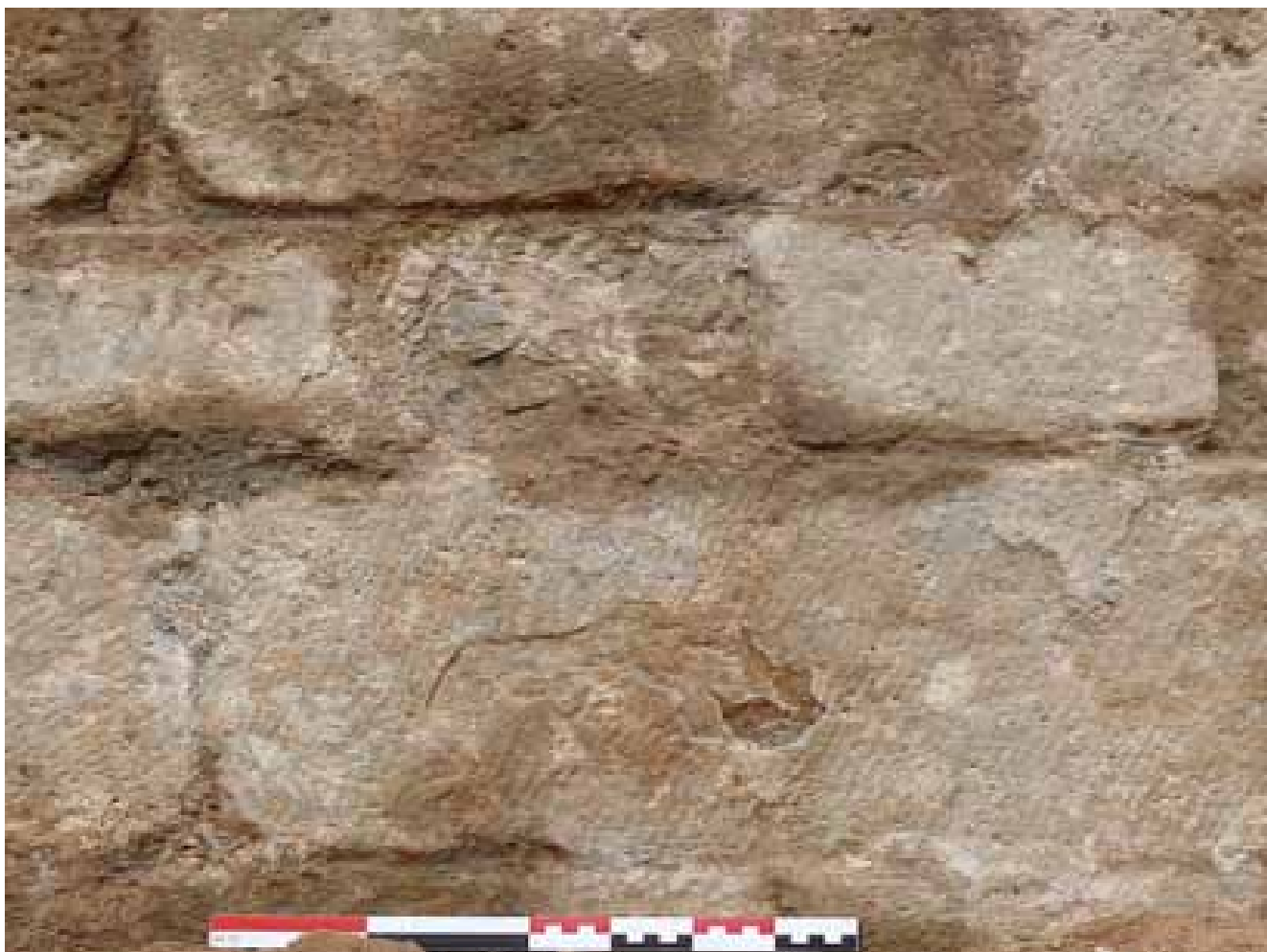
Natuurstenen parement (spoor S13) met sporen van fijnwerk op het oppervlak van de brede steenlagen (© Fodio)
