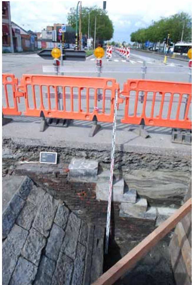
Het kadetalud en brughoofd van de brug ter hoogte van de Bredastraat
