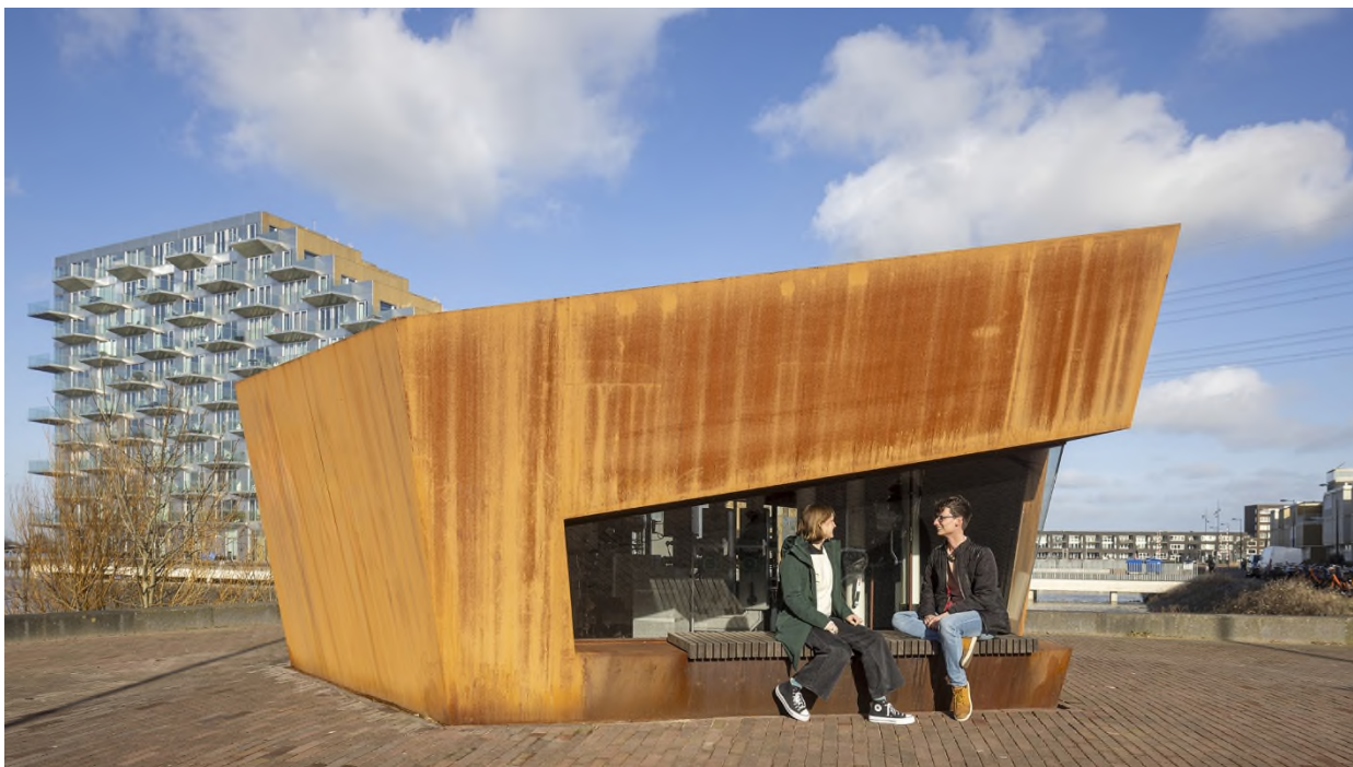
Figuur 8: Warmteoverdrachtstation IJburglaan, Amsterdam (Dingeman Deijns Architects en Heren5 27 )
