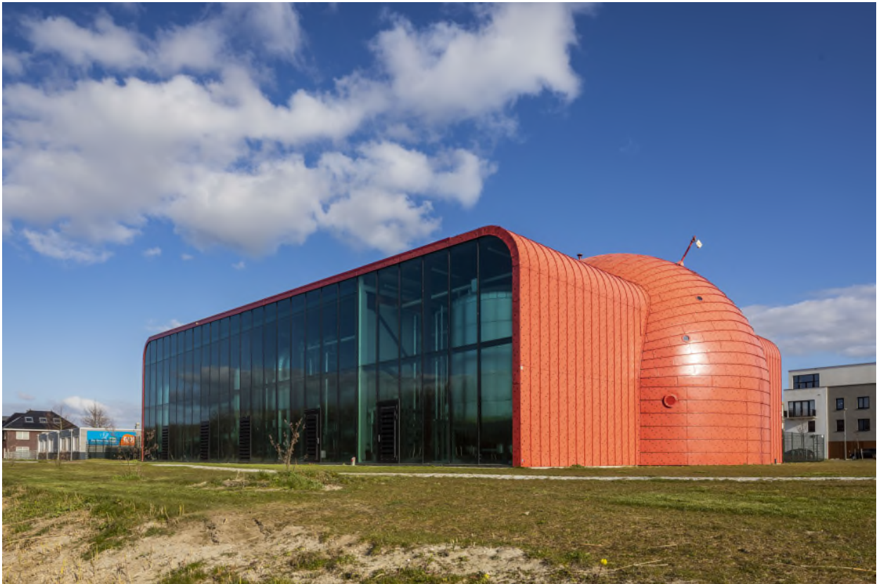
Figuur 10: Warmteoverdrachtstation in Almere (Willem Schutter Architecten 29 )
