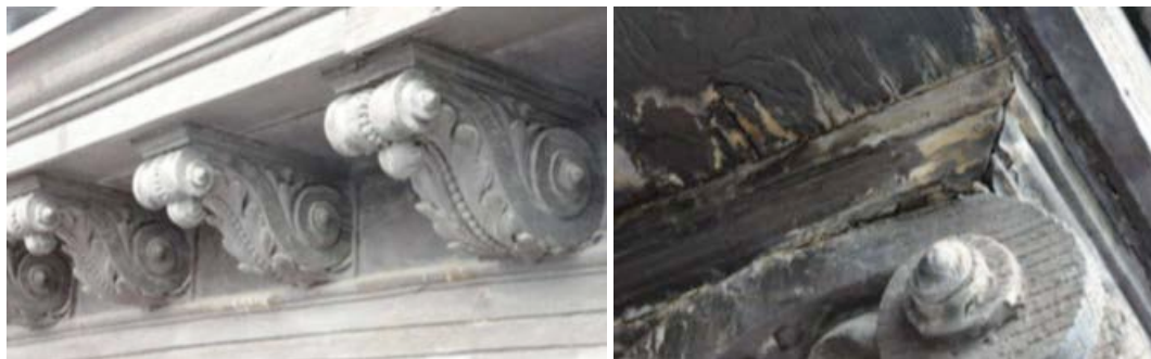
Afbeelding 74: zicht op de gootklossen die de uitkragende bakgoot ondersteunen (foto Origin)
