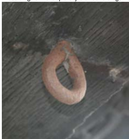
Afbeelding 50: detail van een roestend ankerroog thv de open galerij op de 2e verdieping (foto Origin)
