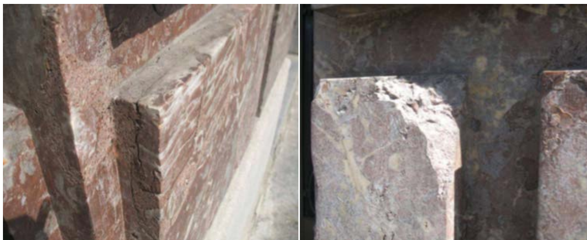
Afbeelding 22: Plaatselijk zijn herstellingen uitgevoerd met stukken marmer die ingelegd zijn (foto Origin)
