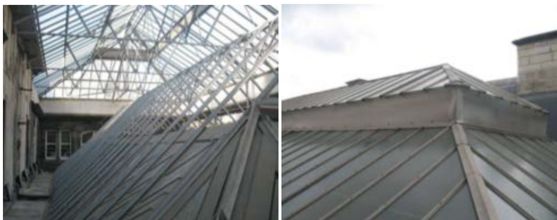
Afbeelding 89: zicht op constructie van de dubbele lichtkoepels boven de centrale trappenhal (foto Origin)
