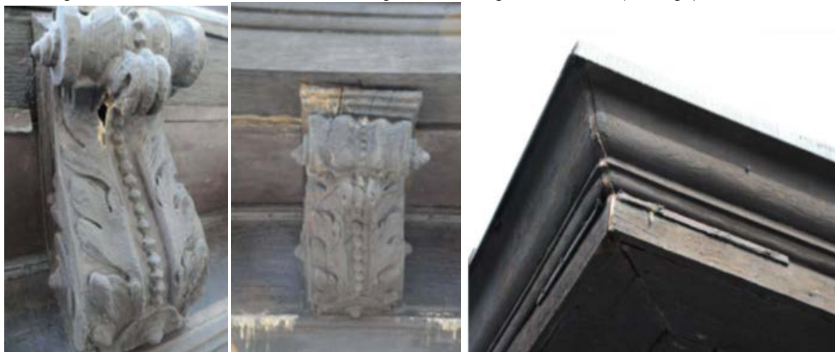
Afbeelding 76: zicht op een sterk aangetaste gootklos. Een zwam of een aantasting door houtborende insecten heeft ervoor gezorgd dat een deel van de klos hol is geworden (foto Origin)
