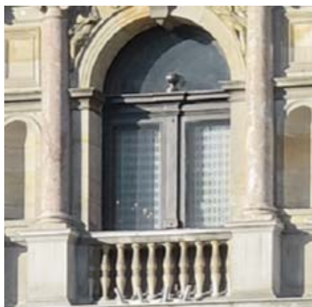
Afbeelding 30: voorbeeld van kruisraam op het schoon verdiep en op de eerste verdieping
