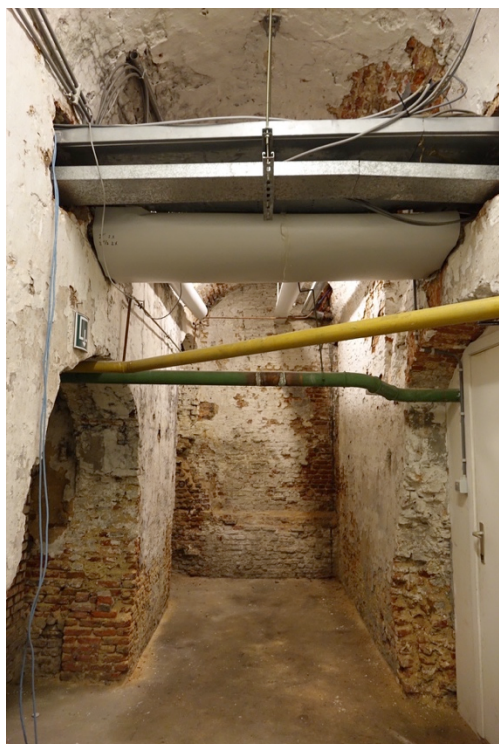
Afbeelding 99: zicht op historische structuur in kelder (foto Origin)
