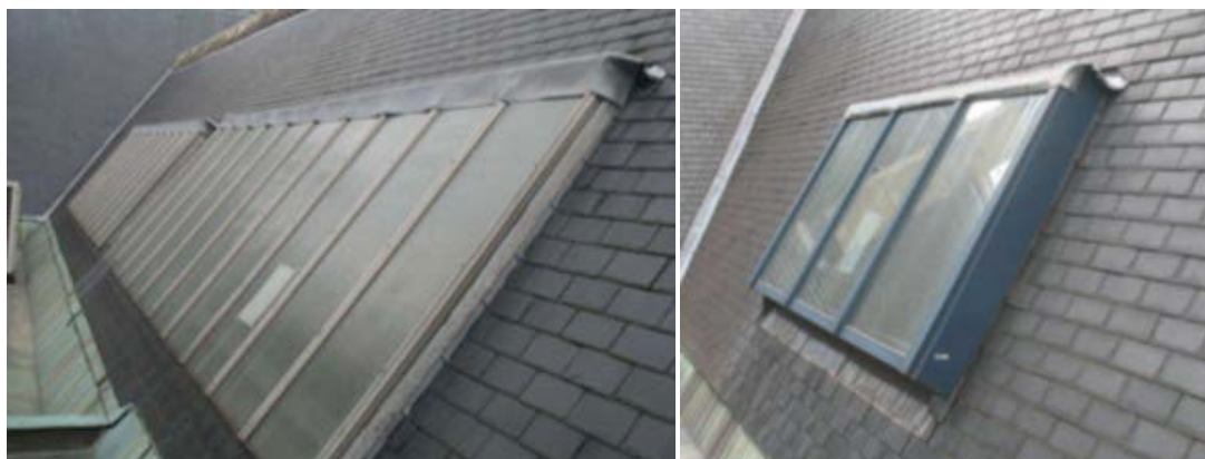
Afbeelding 86: zicht op dakvlakraam welke vervaardigd is met verzinkte metalen profielen met daarin gewapende glasplaten (foto Origin)
