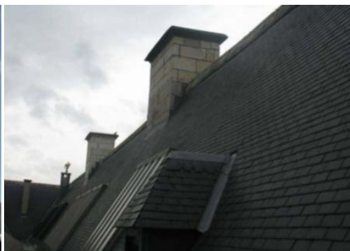
Afbeelding 95: zicht op het buitenste dakvlak van het dak 5 met aanduiding van de ladderhaken. De haken staan te ver uit elkaar (foto Origin)
