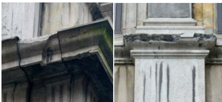
Afbeelding 11 & Afbeelding 12: afscheuring als gevolg van koolstofaders
