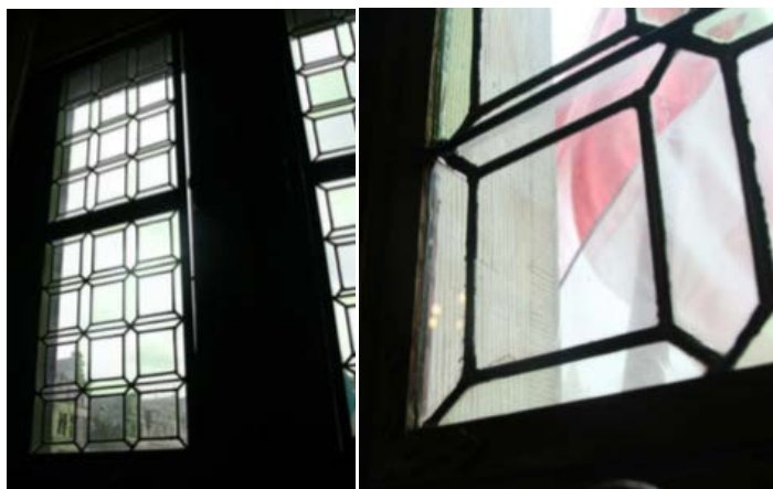
Afbeelding 38: zicht op een glas-in-loodpaneel van de Trouwzaal. Het paneel is wat uitgezakt en hangt scheef
