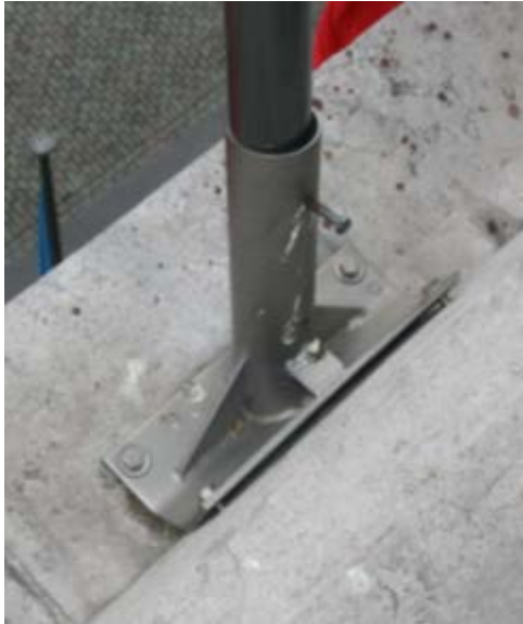
Afbeelding 53: zicht op een vlaggenmasthouder (foto Origin)
