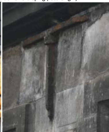
Afbeelding 51: zicht op een roestend ankerroog (vermoedelijk een oude vlaggenmasthouder) met schade aan de blauwe hardsteen tot gevolg (foto Origin)
