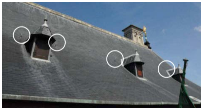
Afbeelding 95: zicht op het buitenste dakvlak van het dak 5 met aanduiding van de ladderhaken. De haken staan te ver uit elkaar (foto Origin)
