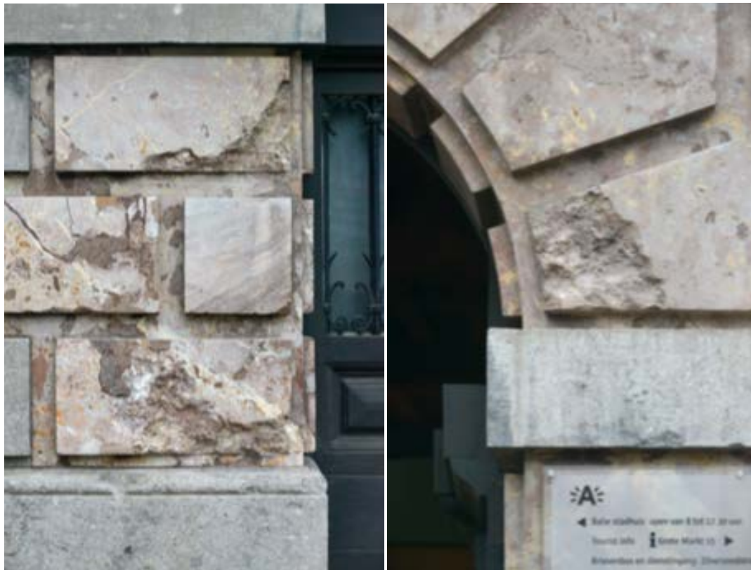
Afbeelding 13 & Afbeelding 14: afbrokkeling van de rode marmer
