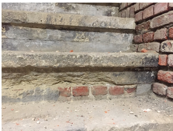
Afbeelding 100: trap die vermoedelijk dateert uit de 16 e eeuw met bakstenen draagstructuur en treden in blauwe hardsteen (foto Origin)
