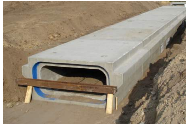
Watertransport in een holle constructie - bron: Lindenbeton.nl
