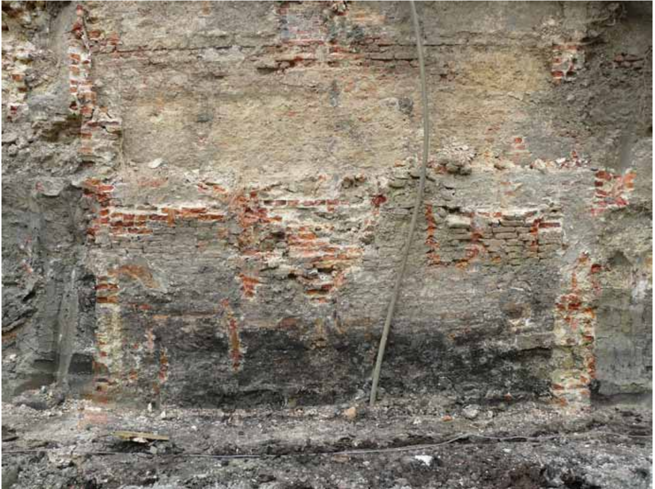
Figuur 15. Constructie S4 na het uitbreiden van de bouwput. Op halve hoogte is de aanzet van een tongewelf te zien.
