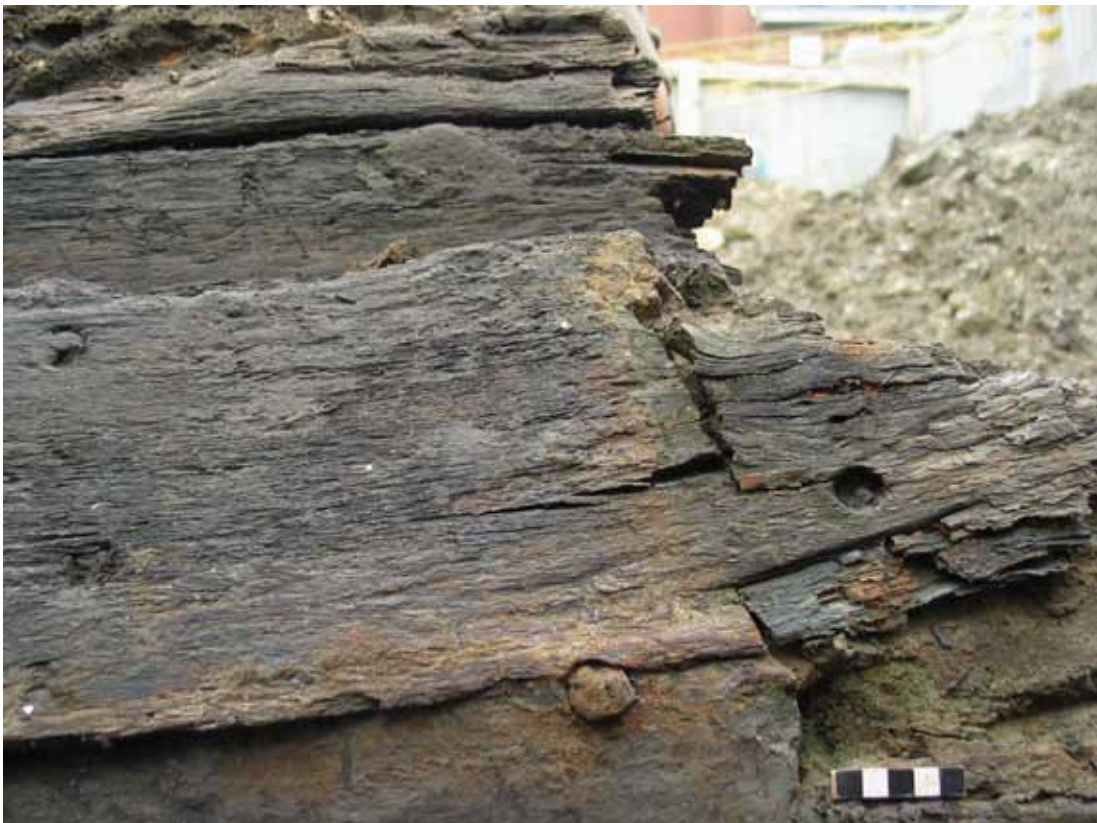
Figuur 24. Detailopname van hergebruikte scheepsplanken S206-208 in de zuidwestelijke hoek van bassin S49
