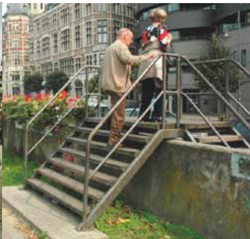
De huidige waterkeringmuur.
